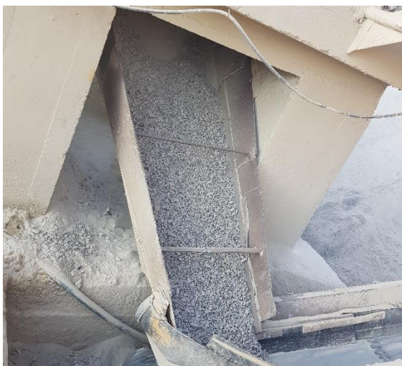
Salida de concreto reciclado ya triturado.
