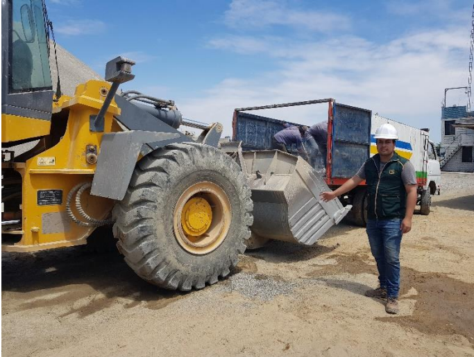
Uso de cargador frontal para descargar el concreto reciclado del camión en el que se transportó desde la planta Tubos y Postes SRL.
