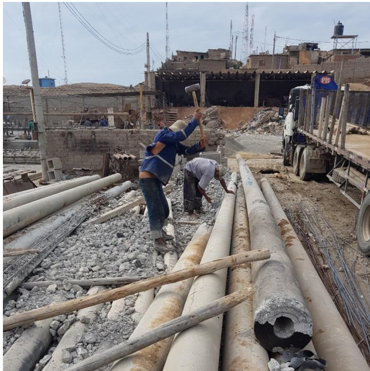
Figura 1. Proceso de demolición de elementos prefabricados en la planta de producción de la empresa Tubos y Postes SRL.
