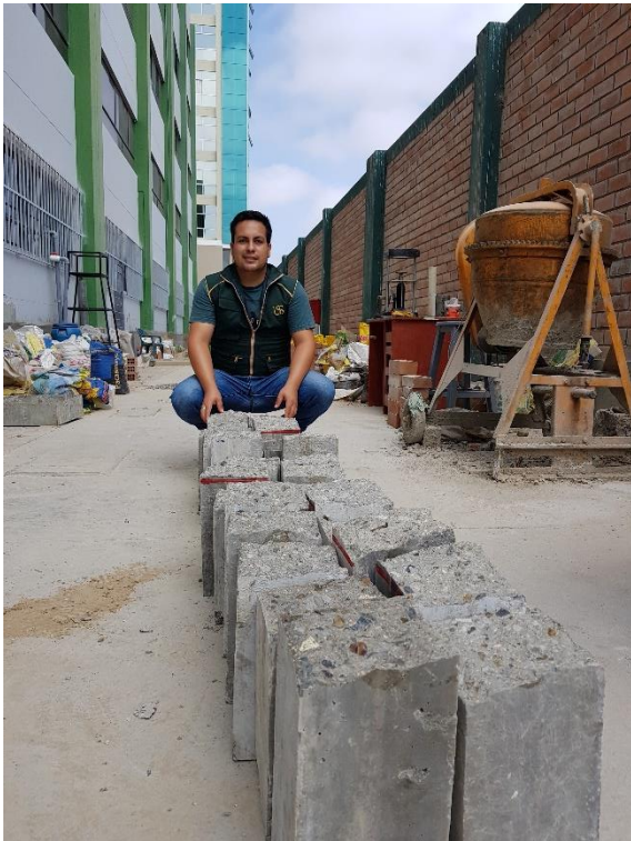
Vigas correspondientes a las resistencias f'_c=280 \text{ kg/cm}^2 luego de ser ensayadas
