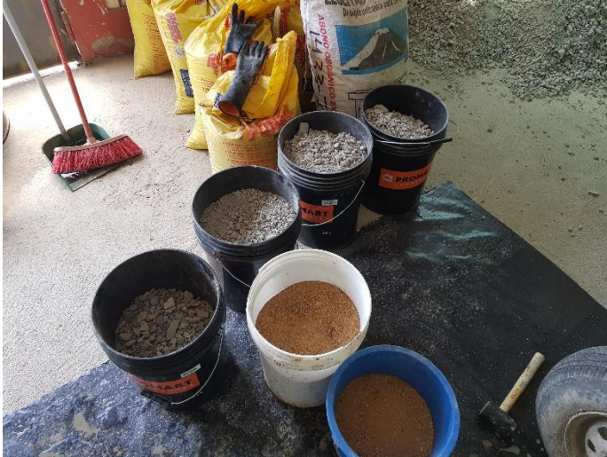
Materiales necesarios para una tanda de concreto
