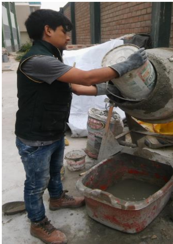
Figura 13. Preparación del concreto patrón, momentos instantes donde se observa que el agregado es llevado al trompo para posteriormente ser mezclado.
