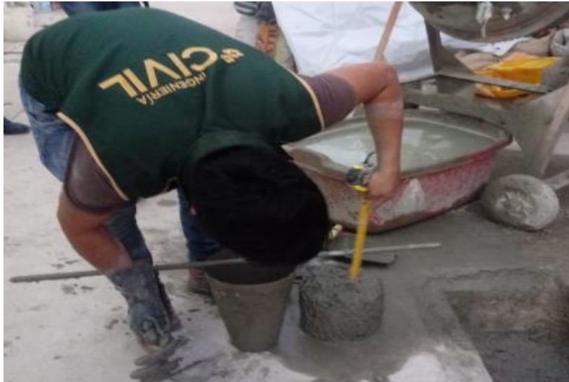
Figura 16. Ensayo de asentamiento del concreto con el cono de Abrams.
