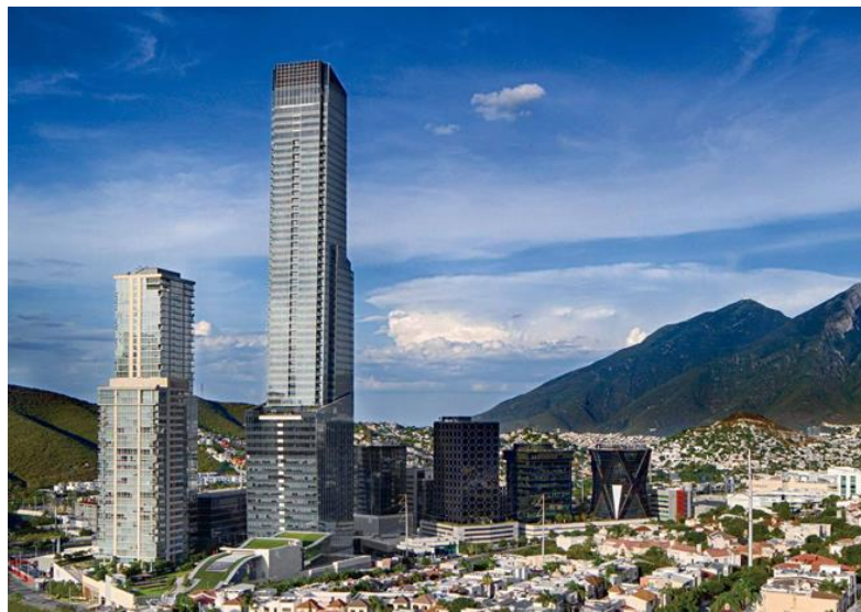
Figura 1. Torre KOI, ubicada en la zona Metropolitana de Monterrey – México.
