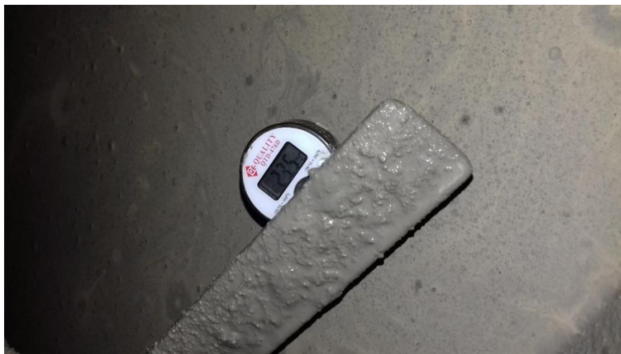
Figura 15. Momento donde se introdujo el termómetro de bolsillo portátil para medir la temperatura del concreto
