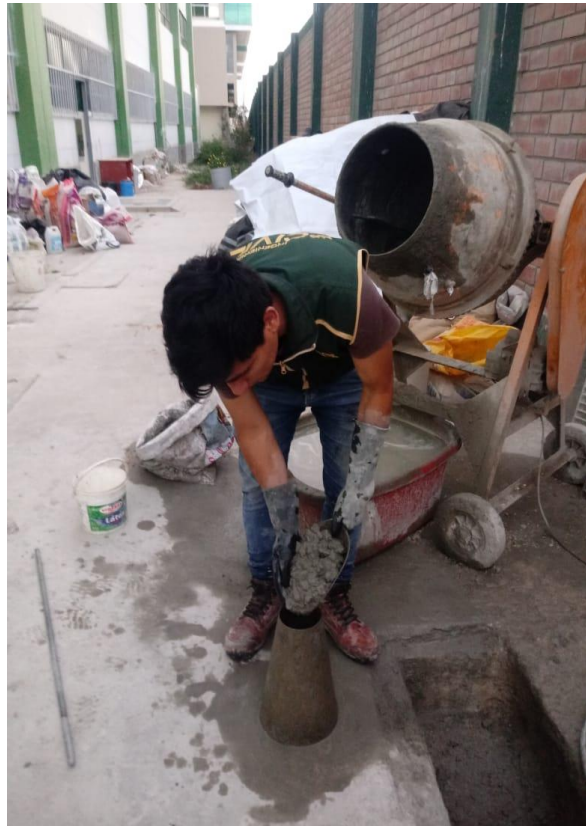
Figura 71. Ensayo de consistencia del concreto.
