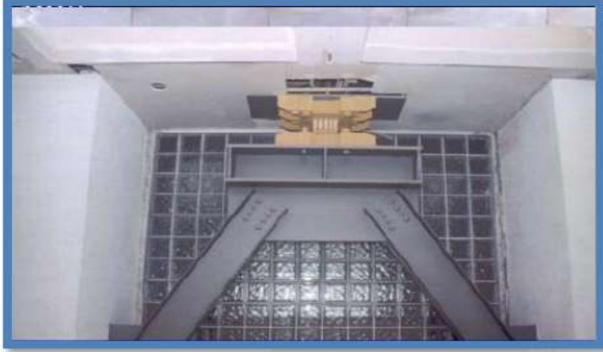
Figura 21: Dispositivo de amortiguación por fluencia.
