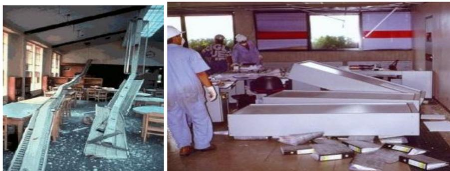
**Figura 14.** Colapso de elementos no estructurales en escuelas durante sismos
