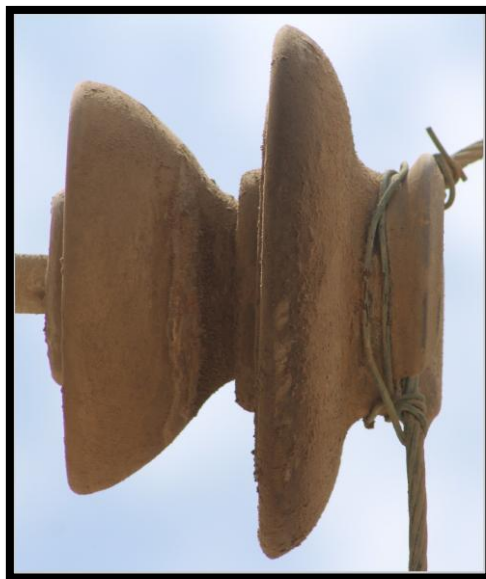
Figura 18: Imagen original de un aislador cerámico. Fuente: Propia.
