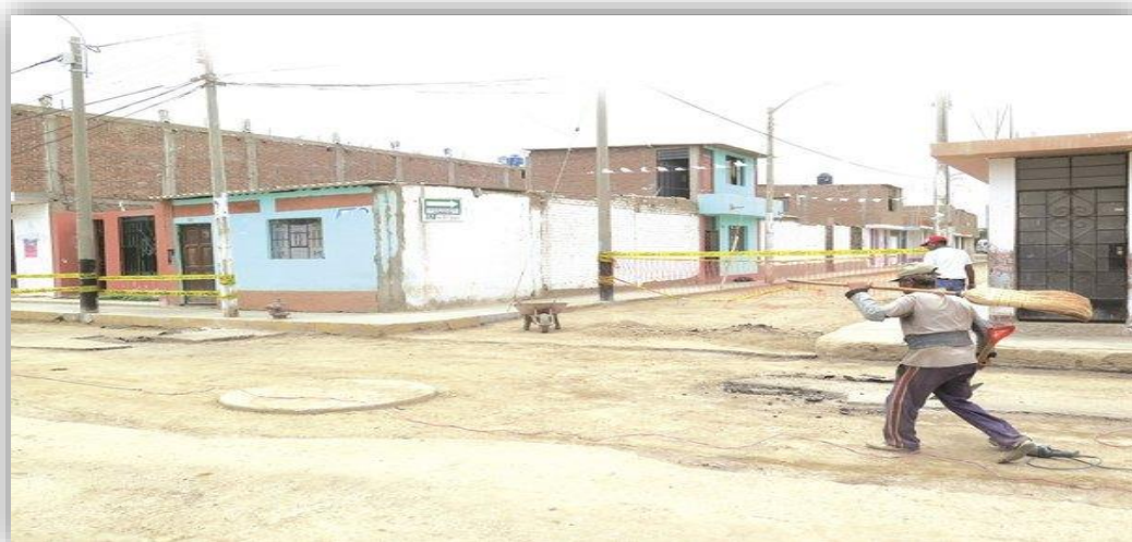
Ilustración 6: Vista de la Falta de Obras Viales en Pisci
