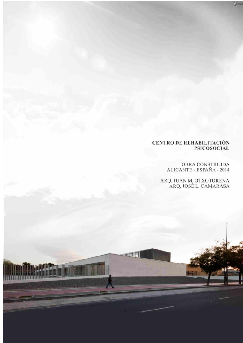
Figura 4: Referente proyectual constructivo, obra construida
