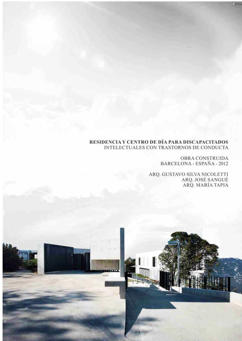
Figura 5: Referente proyectual constructivo, obra construida
