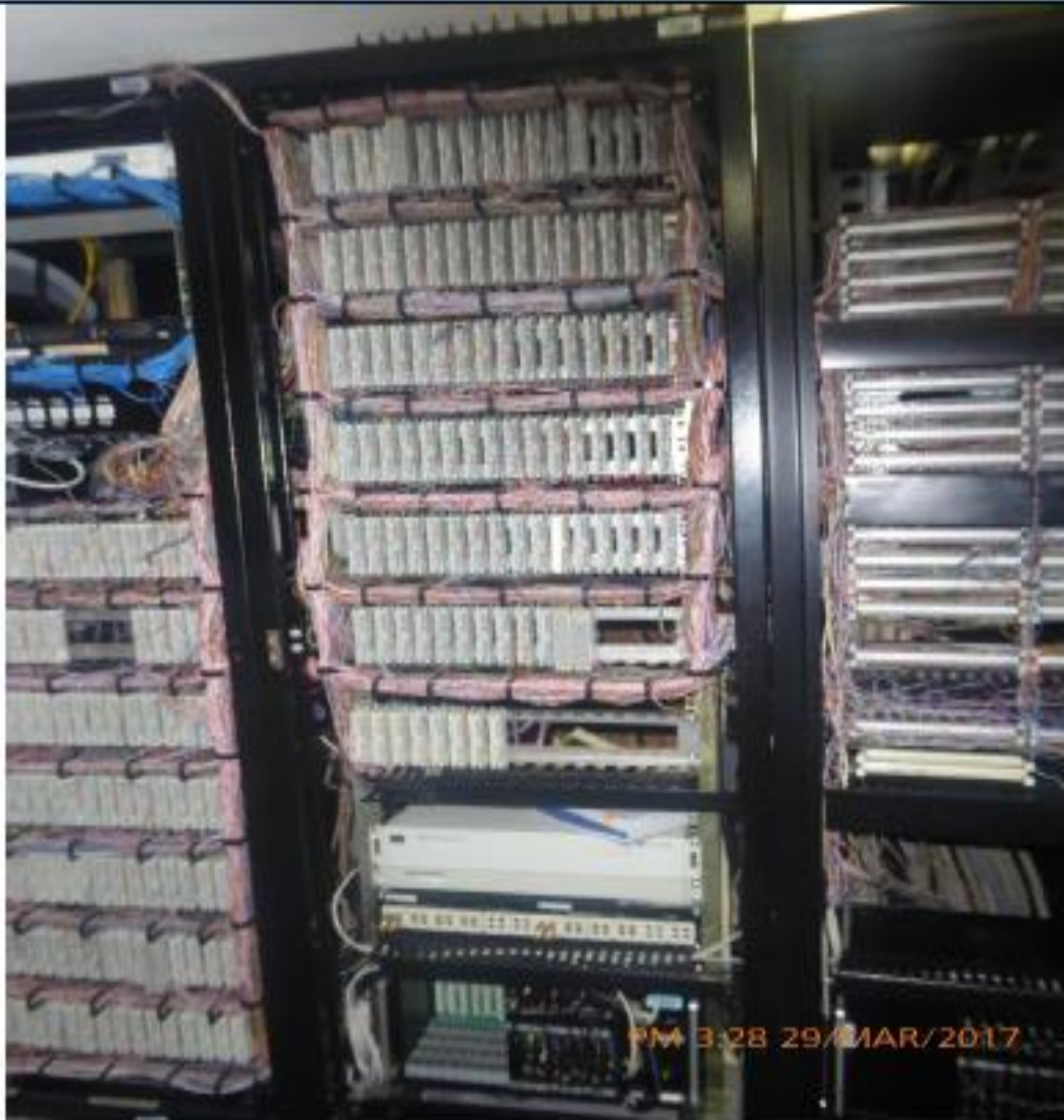
FOTO 3 – CONDICIONES DEFICIENTES “A”.
