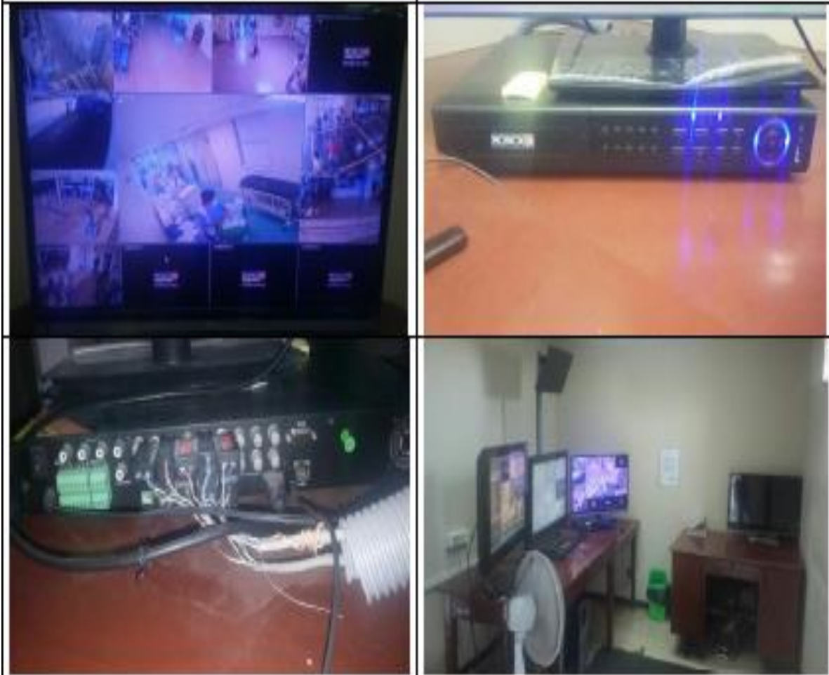
FOTO 8 – AMBIENTE DE LA CENTRAL DE MONITOREO HNERM
