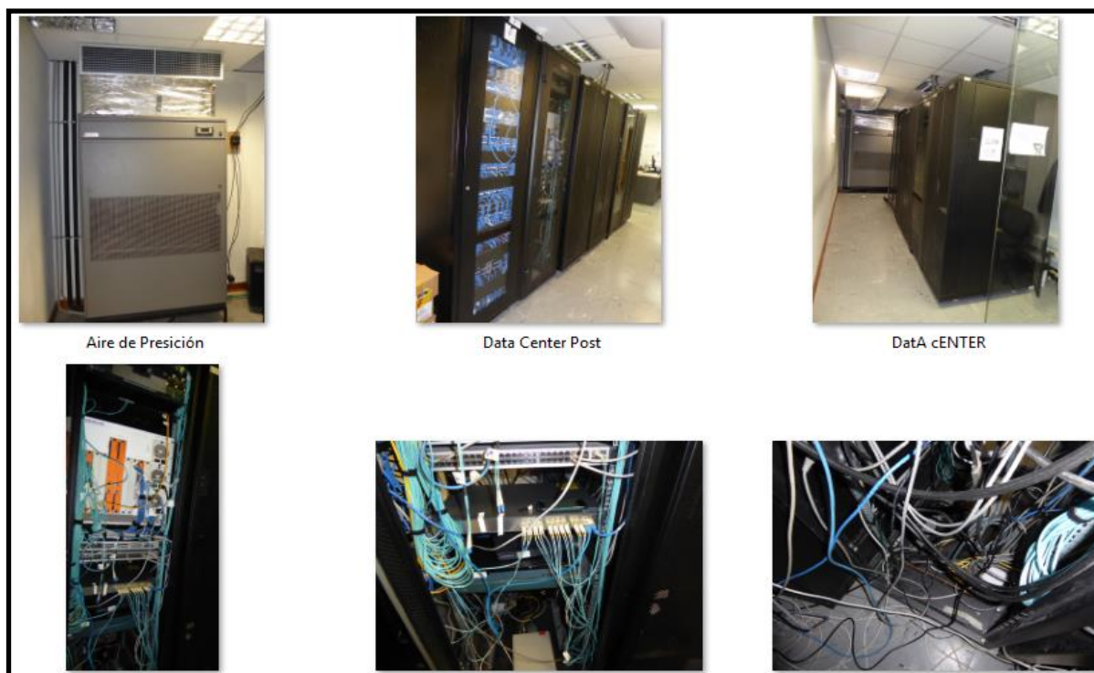
Figura 9. Trabajos Realizados en el Data Center del HNERM EsSALUD. Fuente: Oficina de Soporte Informático del HNERM EsSALUD (2017).
