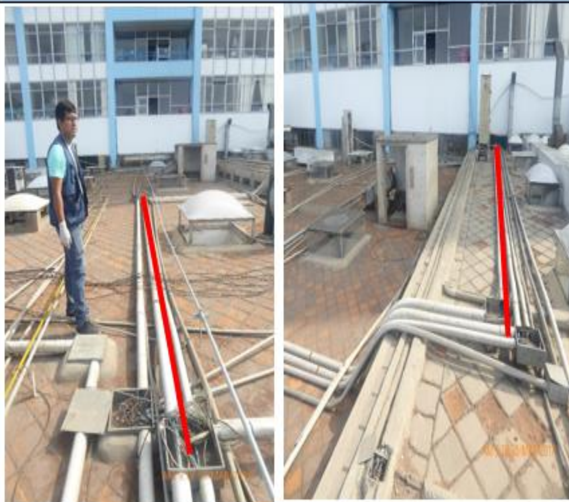
FOTO 2 – ROSETA DE CONEXIÓN INTERNA
