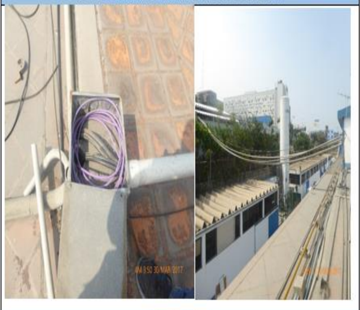
FOTO 8 – RECORRIDO EXTERNO A POSTE O BUZON “A”
