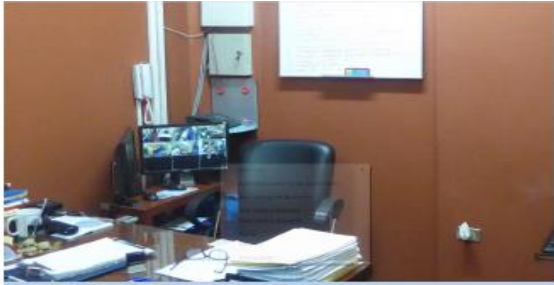
FOTO 09 – CENTRAL Y CAMARAS UBICADAS EN AREAS DE SALUD
