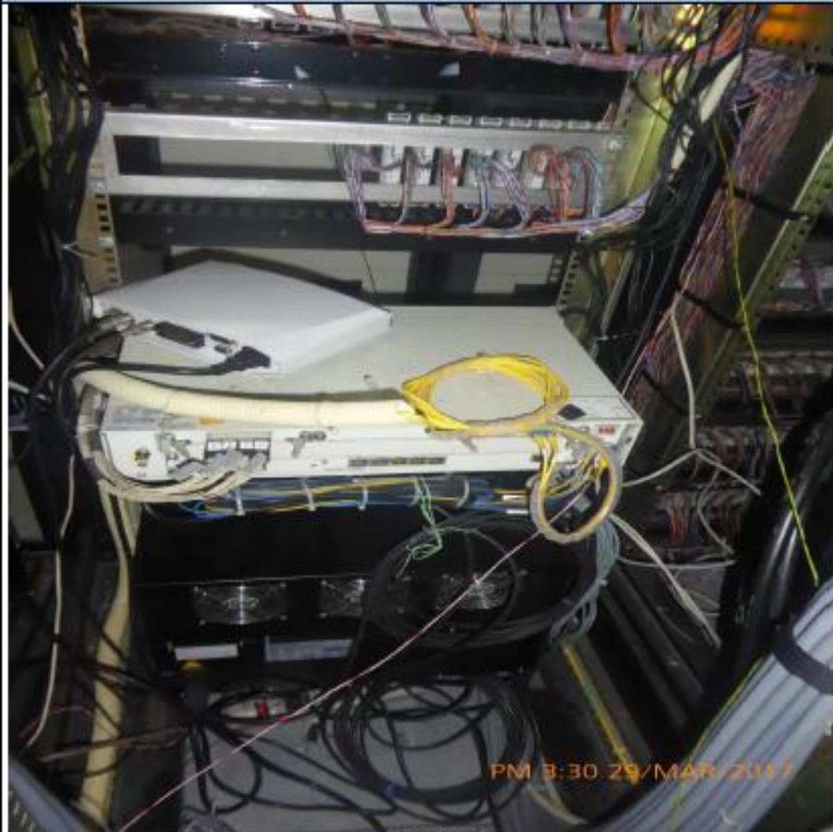
FOTO 7 - CONDICIONES DEFICIENTES "E".
