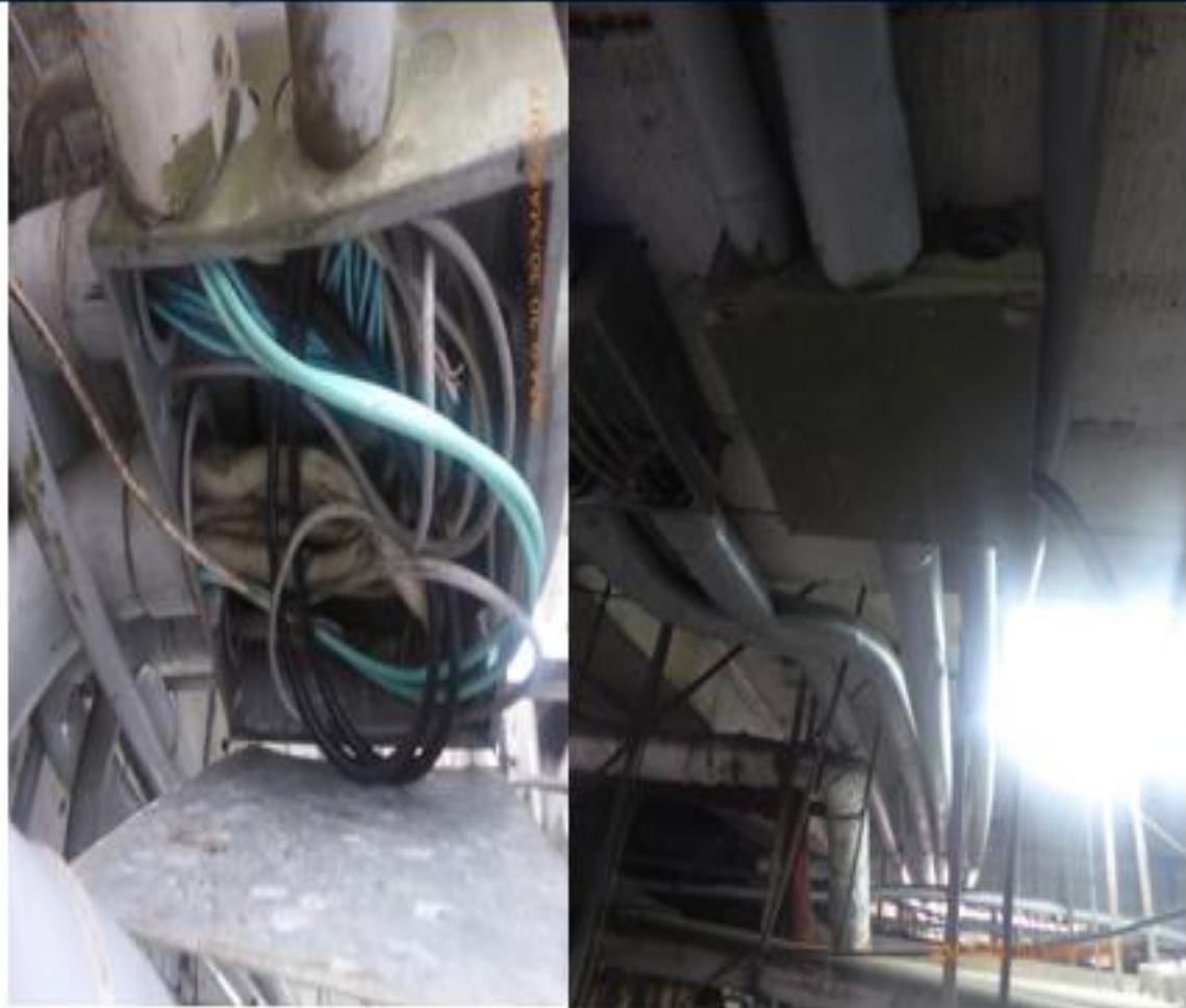
FOTO 4 – RECORRIDO INTERNO "B"
