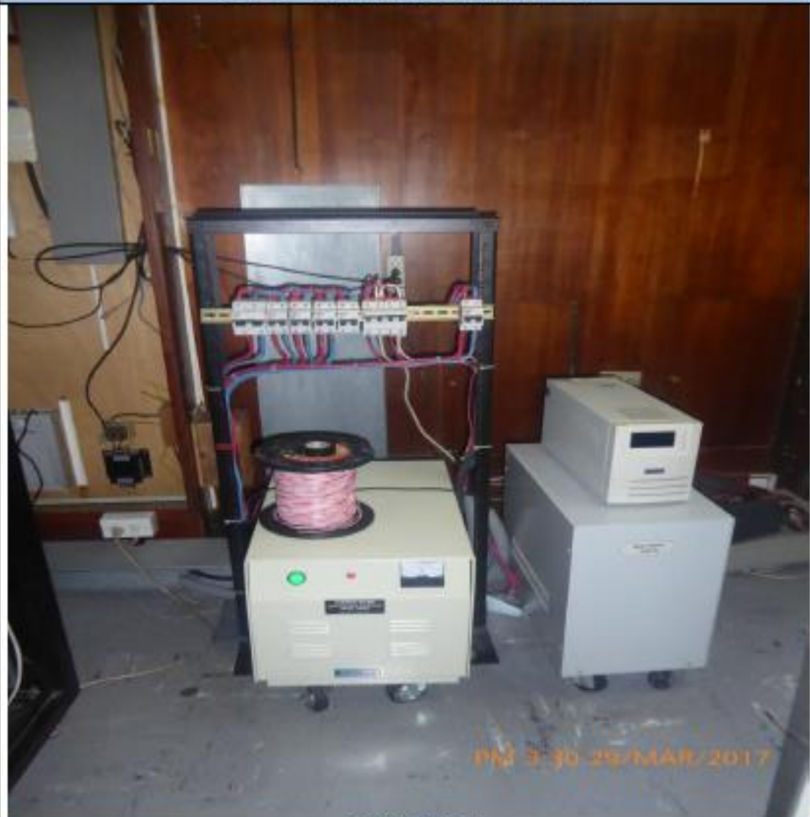
FOTO 6 - CONDICIONES DEFICIENTES "D".
