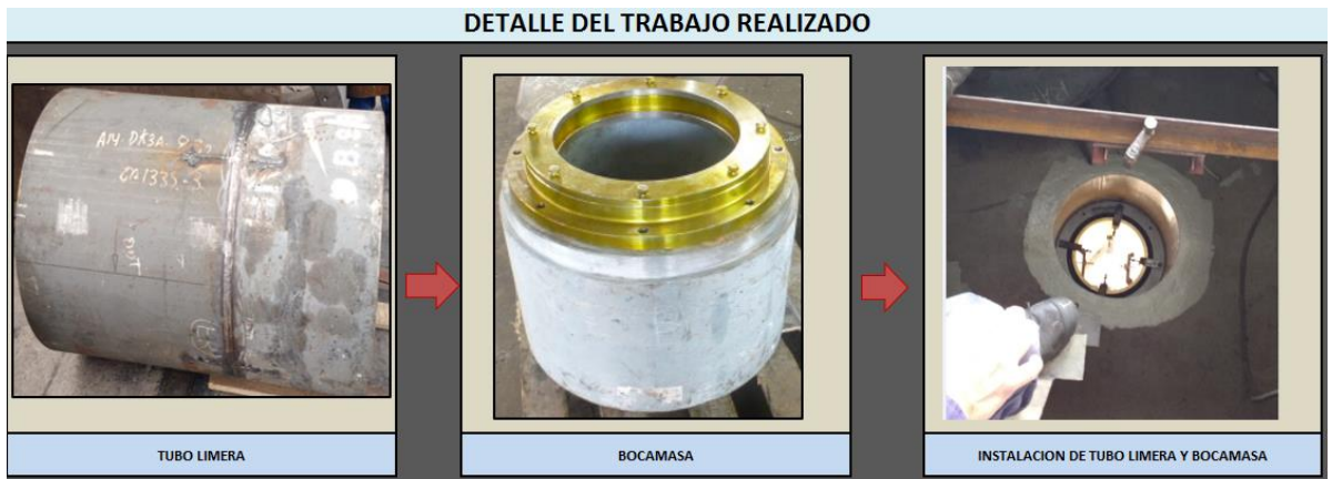
Figura Nro. 36 Detalle del trabajo realizado del montaje del tubo limera
