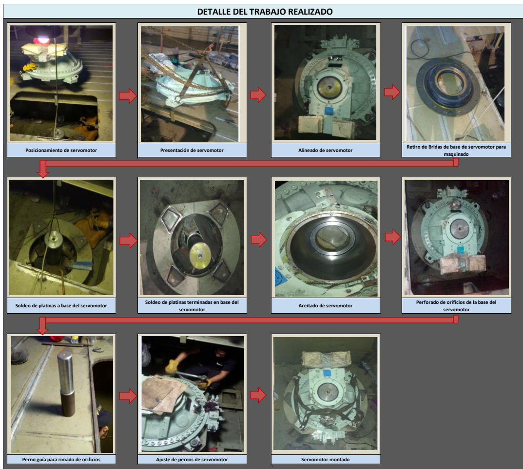
Figura Nro. 44 Detalle del Proceso de trabajo Realizado del Tubo Limera
