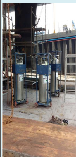
Enfriamiento de pernos de pala timón en cilindros de nitrógeno
