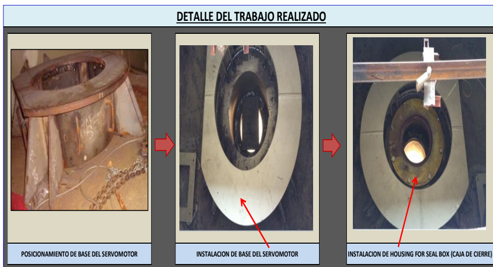
Figura Nro. 40 Detalle del Trabajo realizado en el Montaje de Base de Servomotor
