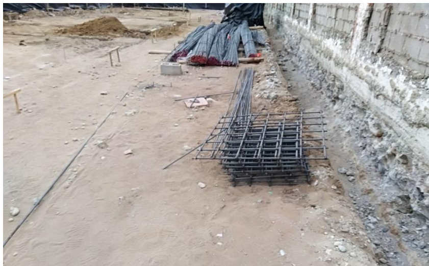
Figura 2. Fierro Corrugado Tirado en plena Obra-Reque
