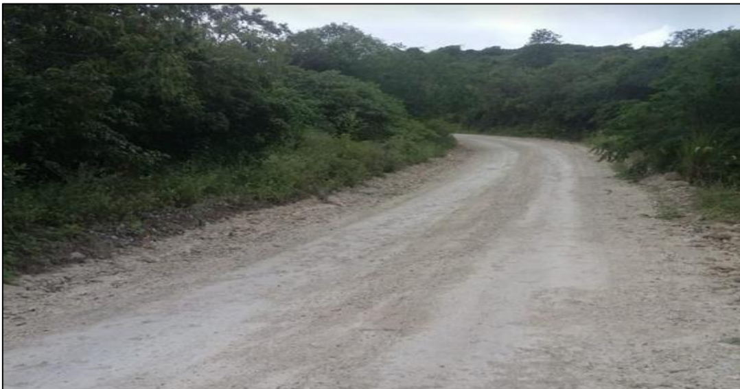
Figura 4. Carretera después del mantenimiento a nivel de afirmado
