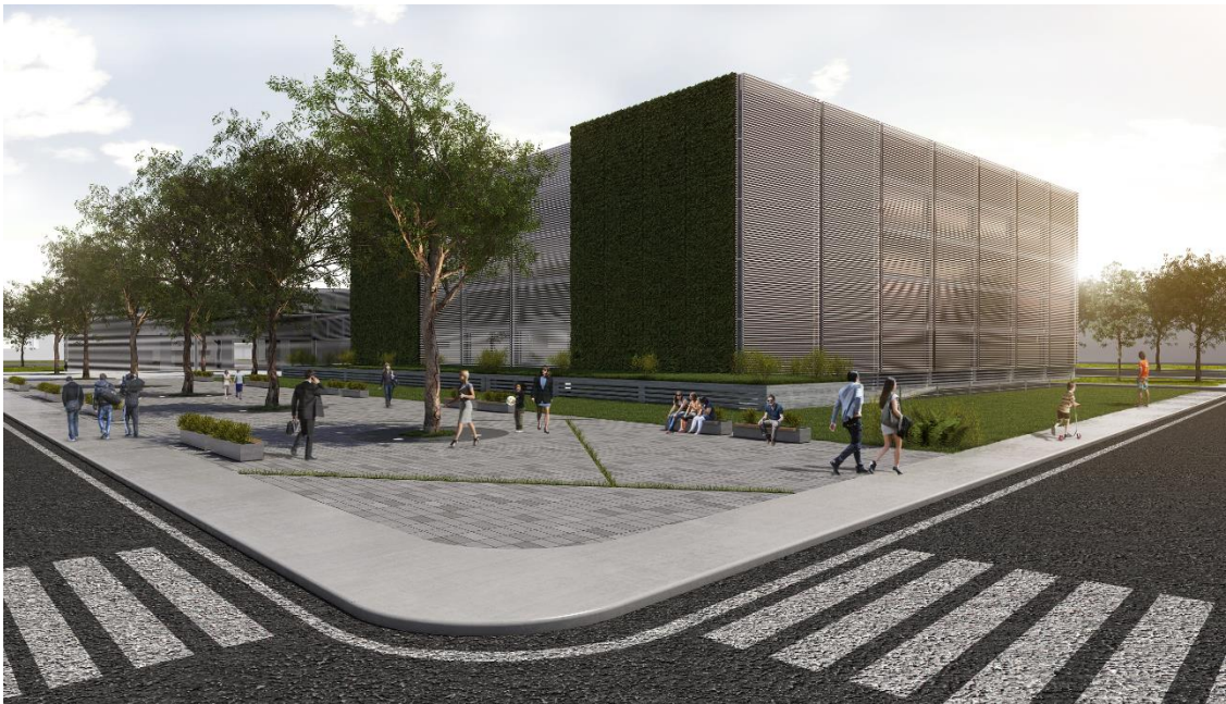
Figura 25: Edificio – Espacio Publico
