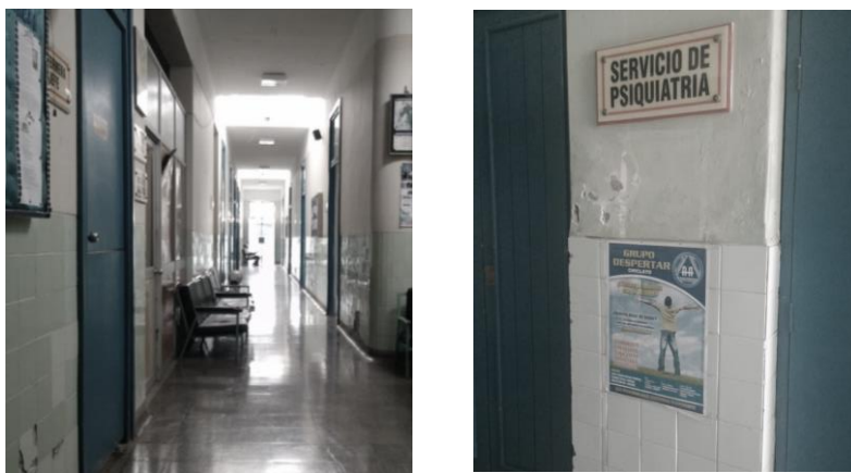
Figura 23: Interior del pabellón de psiquiatría, infraestructura (estado actual)
