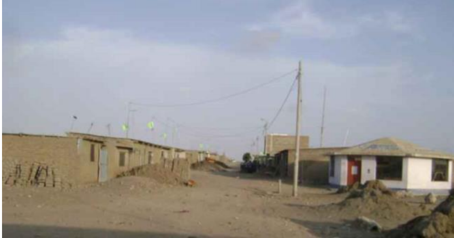
Figura 57: Estado Actual de las vivienda en Reque
