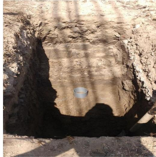
*Figura 19* Excavación de Calicata (h=1.50m)
