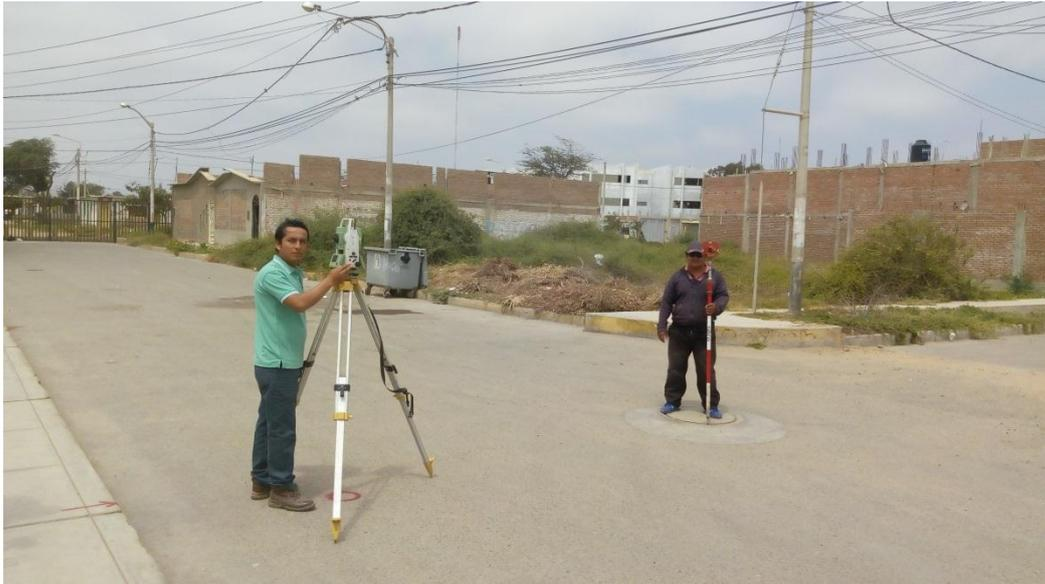
**Figura 15** Estación 1 Lectura de Cotas de tapas de Buzones (Rasante)
