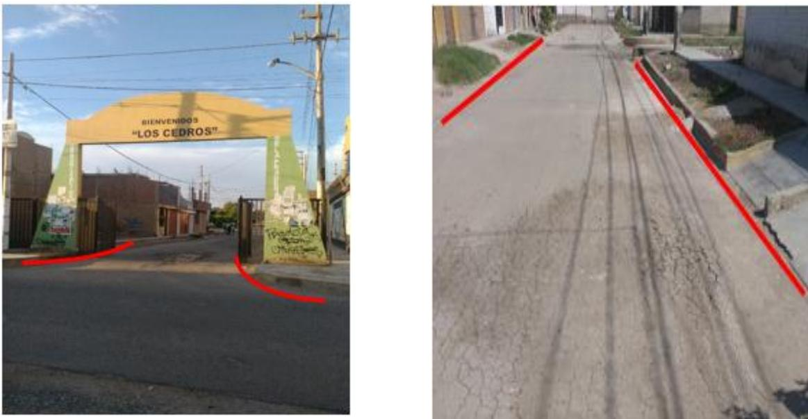
**Figura 2** Vías urbanas en Urb. La Pradera y los Cedros de la Pradera con inexistente Red de Drenaje Pluvial Urbano.
