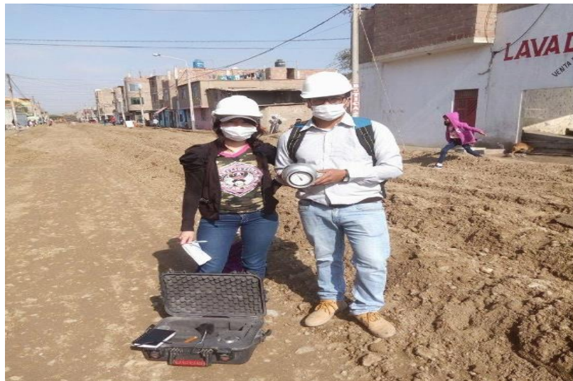
Figura 88. Control de humedad con el humidómetro o Speedy.
