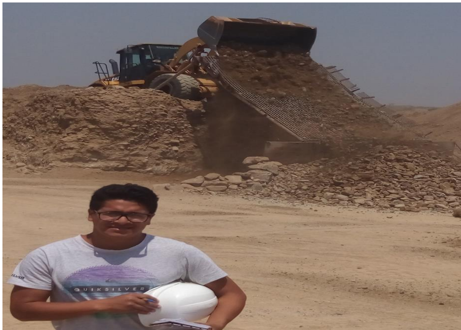
Figura 29. Preparación del material en cantera Tres Tomas.
