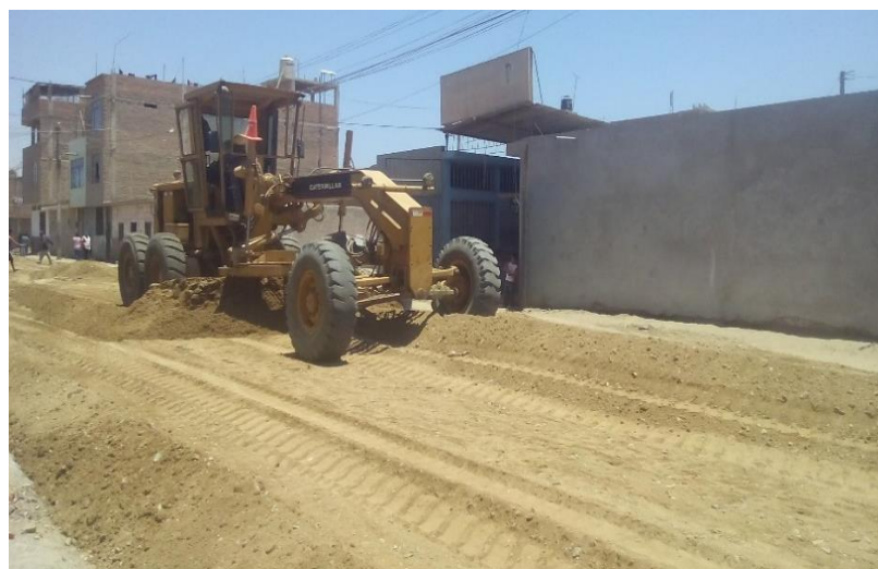
Figura 71. Motoniveladora Cat de 159 KW ejecutando el batido del material para base.
