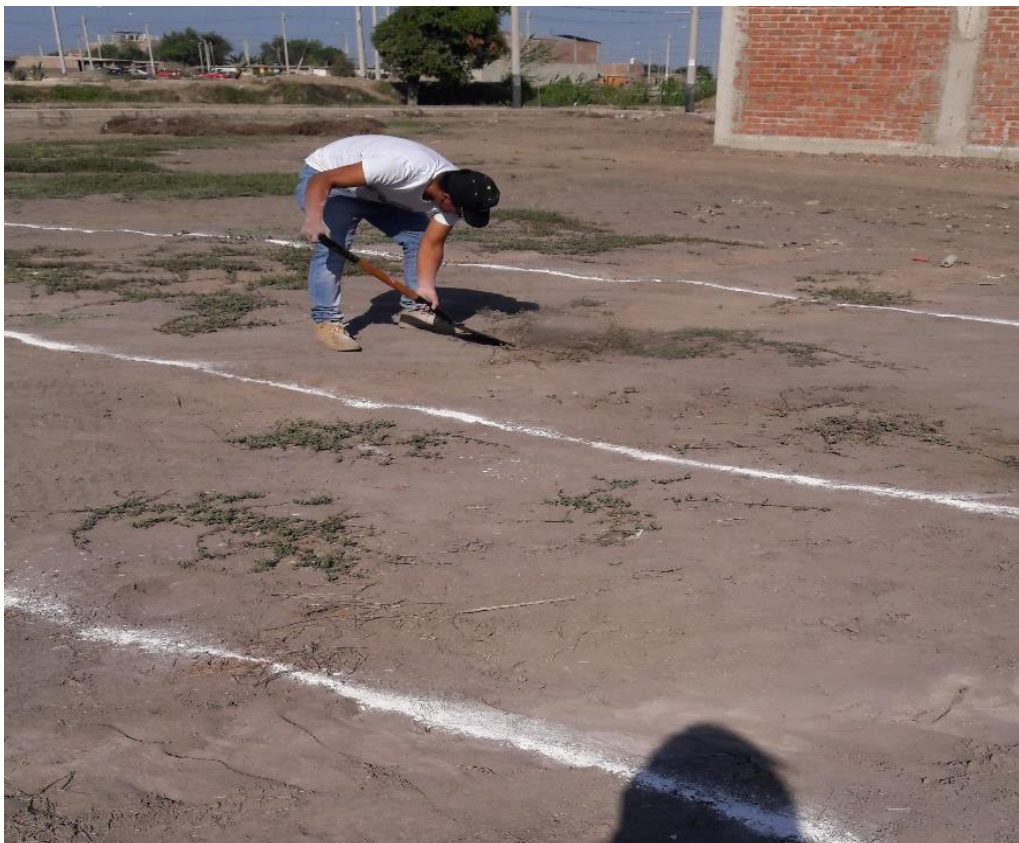
Figura 73. Limpieza y desbroce de la Zona 2.
