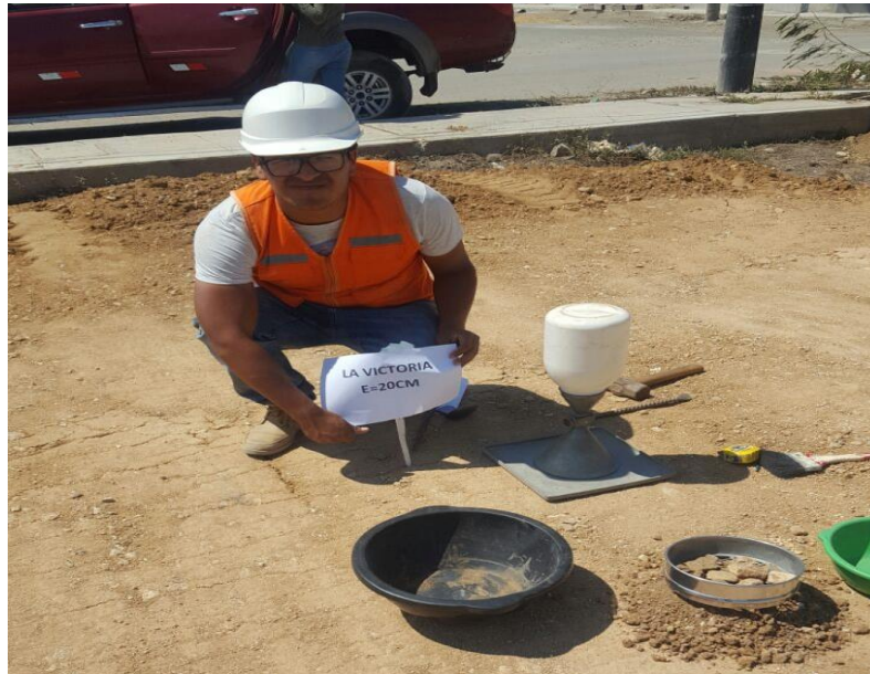
Figura 83. Cono de arena en el agujero excavado – Zona 2.
