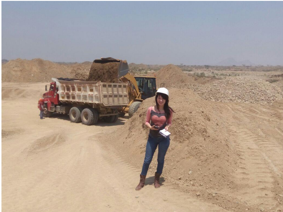
Figura 28. Acarreo del material en la cantera Tres Tomas.
