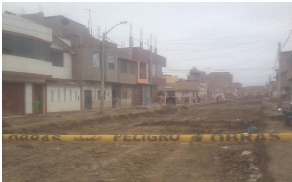
Figura 8. Vista panorámica de la zona 1.
