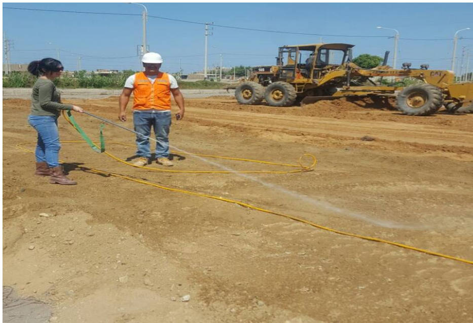
Figura 77. Hidratación de los terraplenes.
