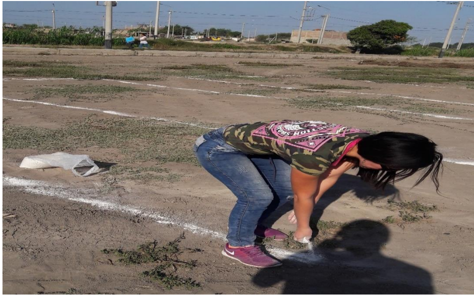
Figura 74. Replanteo de los terraplenes de la Zona 2.
