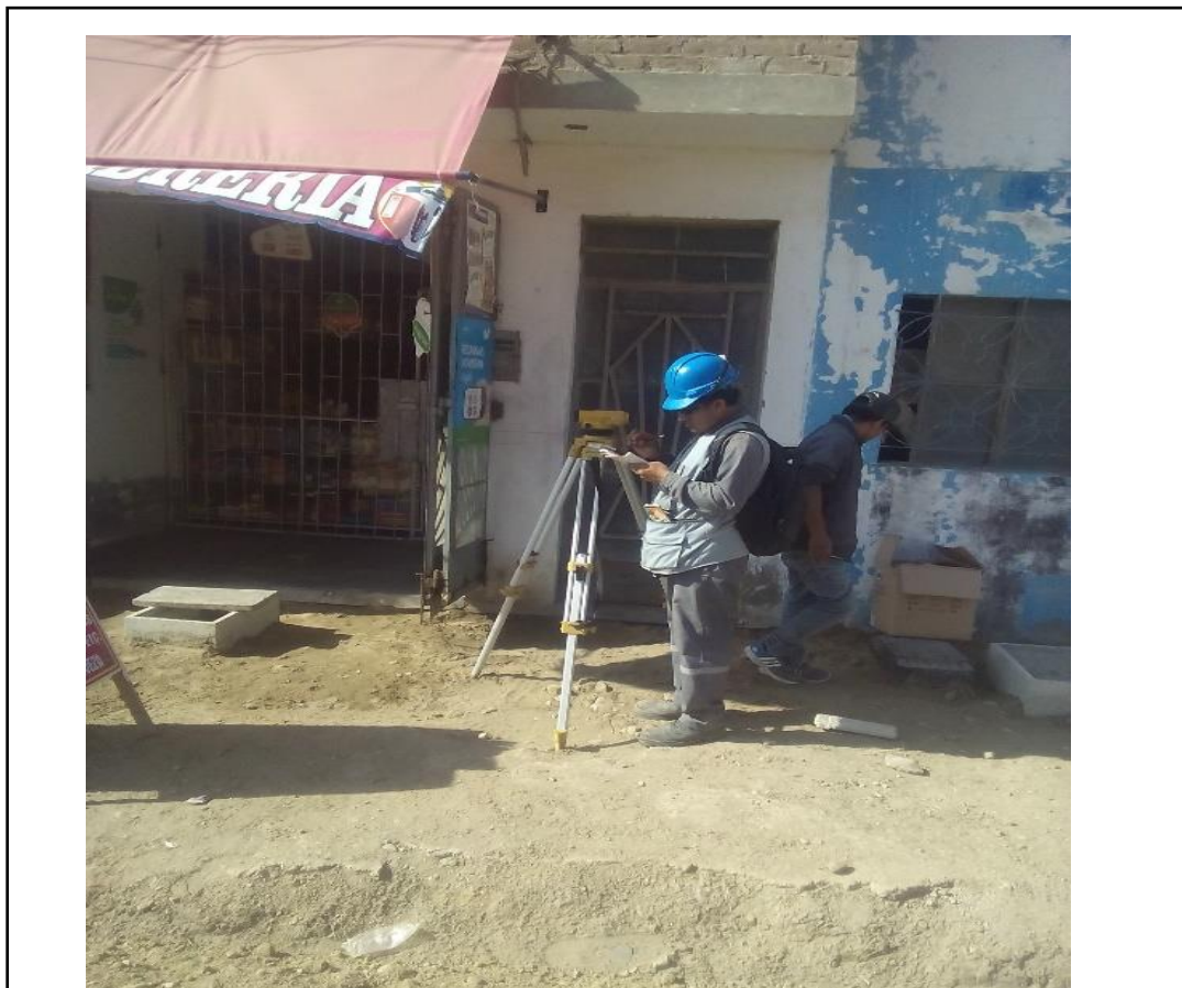
Figura 64. Topógrafo encargado de la nivelación y la colocación de plantillas.
