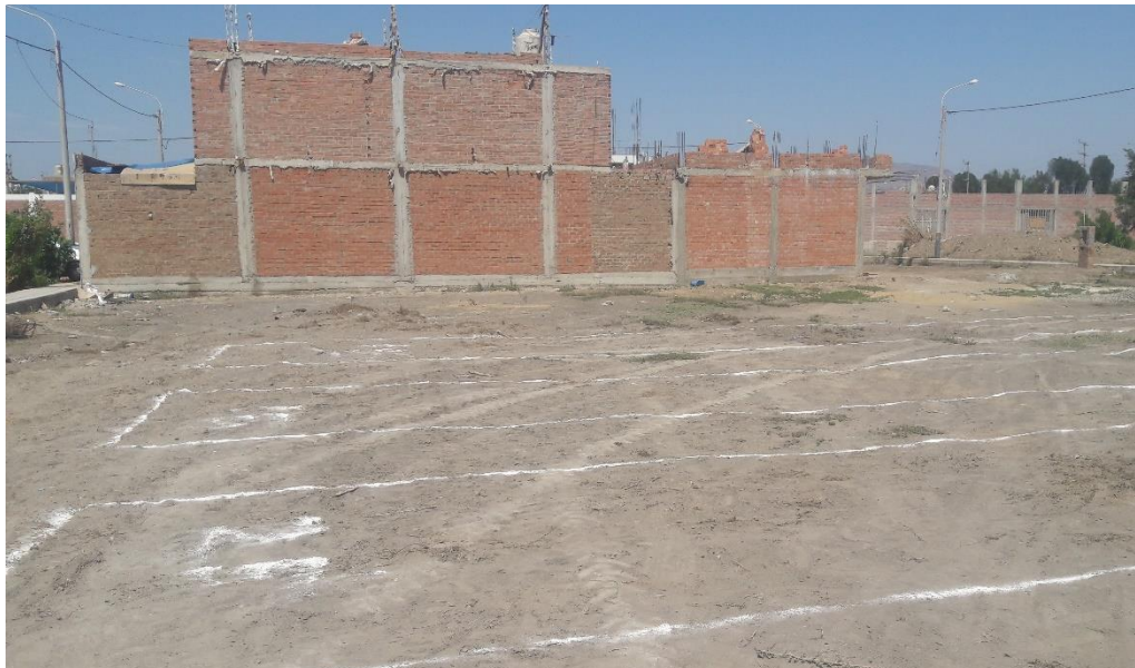
Figura 10. Vista panorámica de la zona 2.
