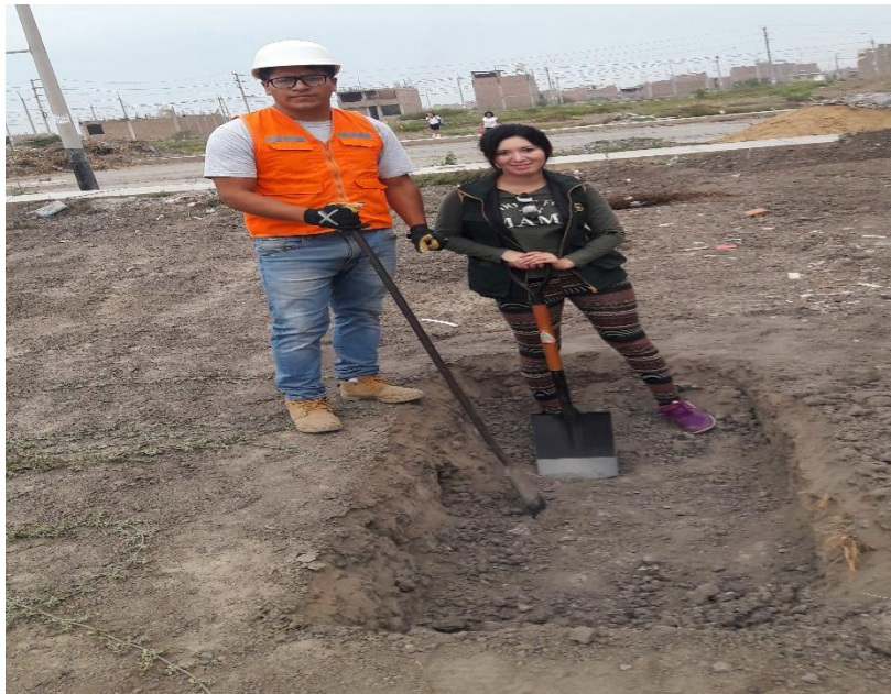
Figura 90. Excavación de 1.50m de profundidad.
