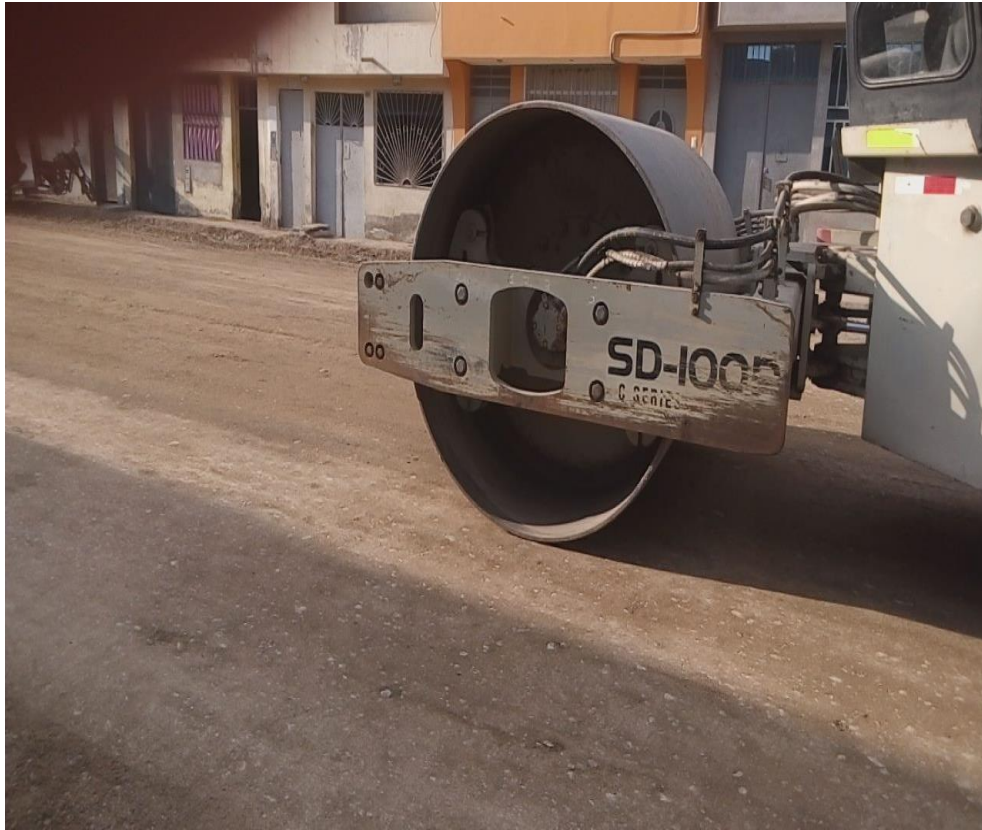
Figura 72. Rodillo liso vibratorio generando energía cada 2 ciclos.
