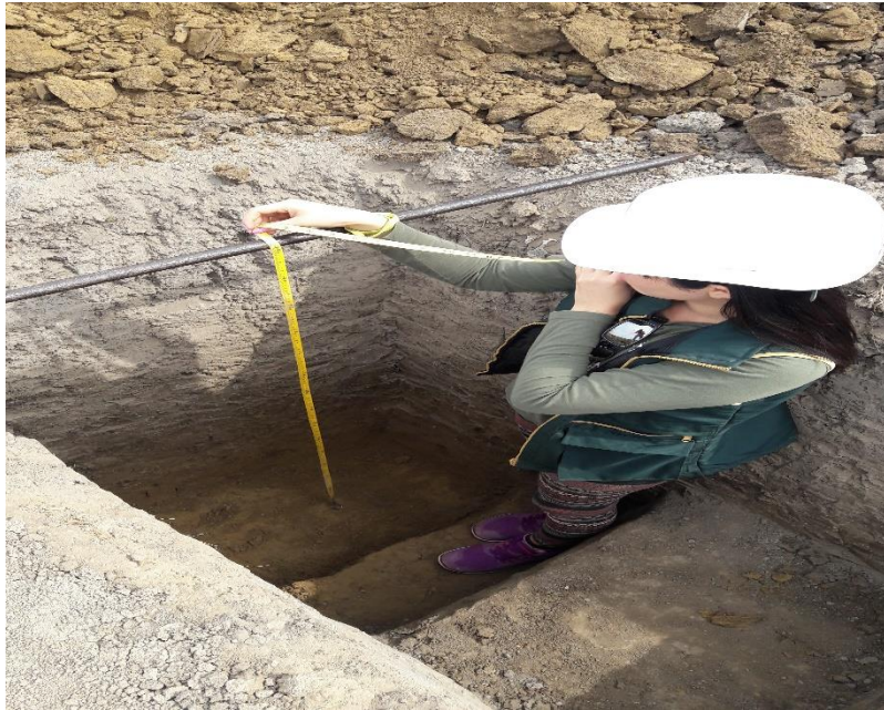
Figura 91. Midiendo la profundidad de la calicata.
