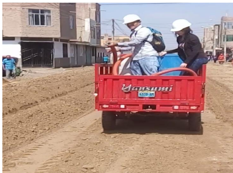
Figura 70. Aplicación de 375 galones de agua mediante una motobomba de 2" en una moto carguera.
