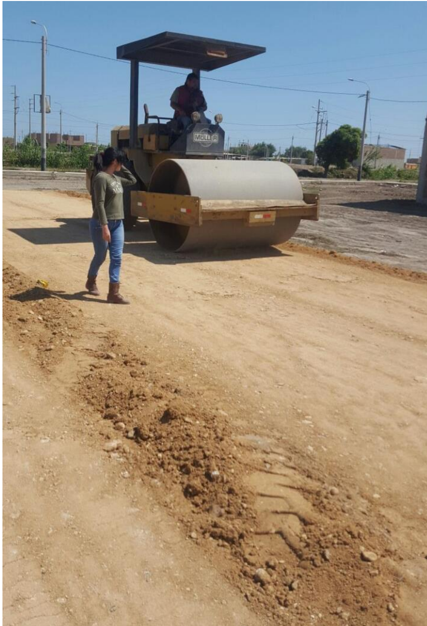
Figura 79. Compactación de los terraplenes.
