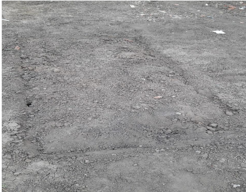
Figura 89. Demarcación de la calicata de 1.5m x 2m.
