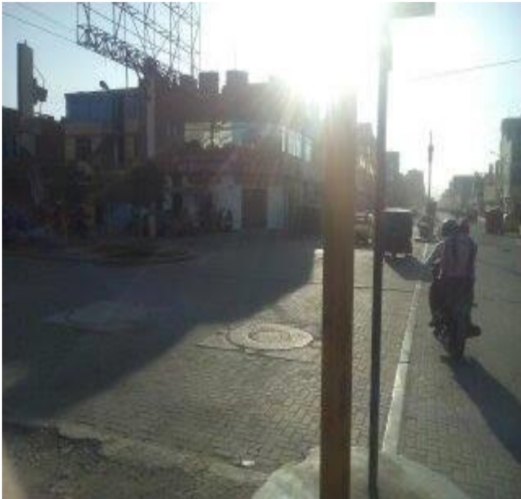
Figura 3. Pavimento deteriorado entre las avenidas México y Sáenz Peña.
