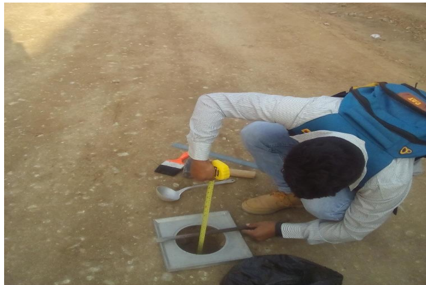
Figura 82. Medida de profundidad del agujero – Zona 1.
