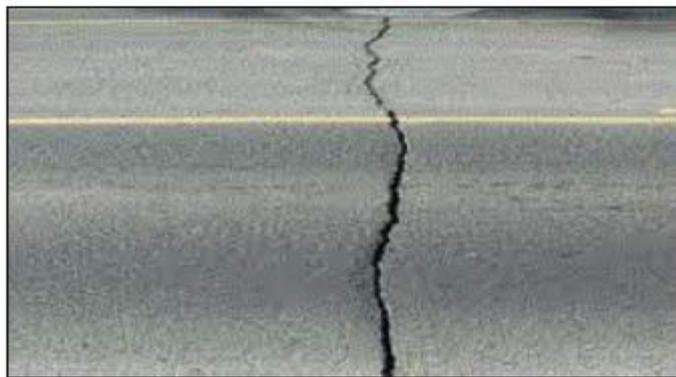
**Figura 7:** Agrietamiento por bajas temperaturas - Diseño Moderno de Pavimentos Asfálticos – S. Minaya G. y A. Ordoñez H.).
