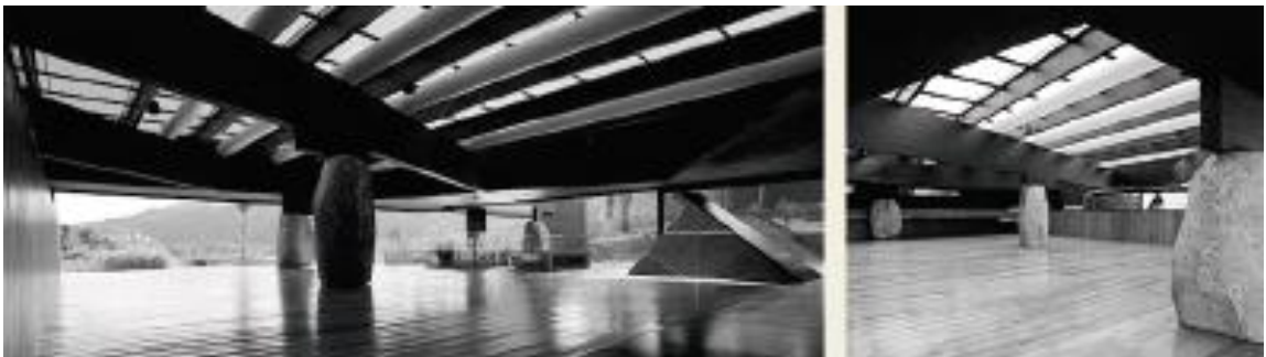
Figura 17: Mercado de roquetas del mar, foto tomada 2014
