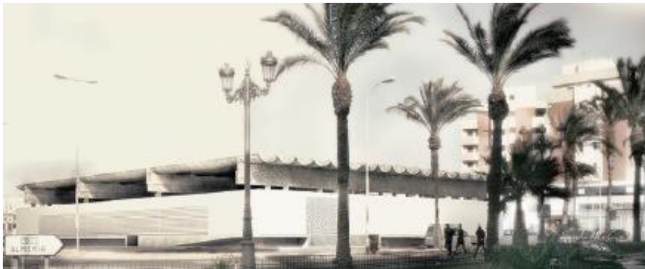
Figura 16: Mercado de roquetas del mar, foto tomada 2014
