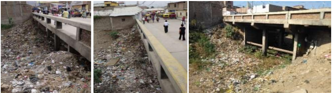
Figura 70: Residuos sólidos en Puente Trapiche – Río Seco, foto tomada en 2016.
