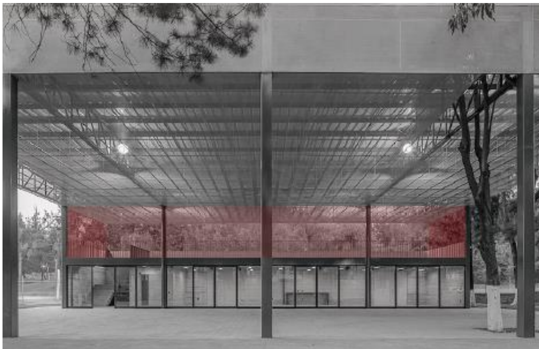
Figura 31: Dilatación entre módulo y cobertura del Centro Comunitario, 2017
