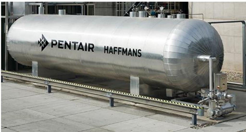
**Figura 24.** Tanque de almacenamiento de CO2 comprimido.
