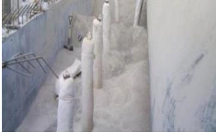
**Figura 5.** Sistema de protección catódica y puesta a tierra
