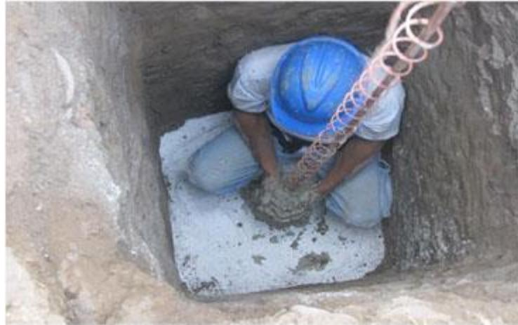
**Figura 6.** Sistema de protección puesta a tierra
