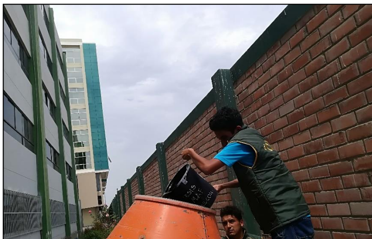
Figura N° 72: Añadiendo emulsión asfáltica a la mezcla humedecida
