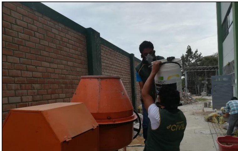
Figura N° 70: Colocación del agregado en el trompo
