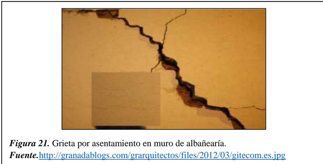
*Figura 21.* Grieta por asentamiento en muro de albañería.
