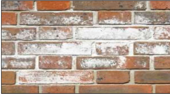
**Figura 25.** Eflorescencia en una pared de ladrillos
