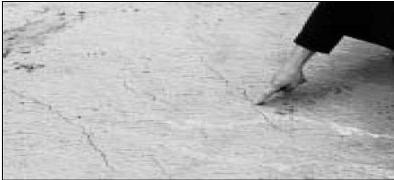
**Figura 17.** Fisuras por retracción plástica en una losa de concreto
