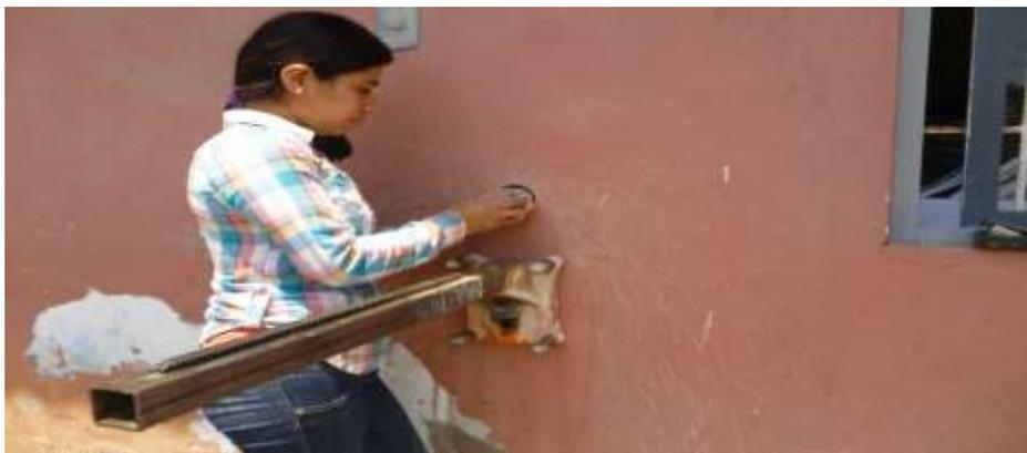
**Figura 117.** Punto de extracción de núcleo de concreto en una columna de una de las aulas del pabellón N°1 de la Institución Educativas Angelito De Dios.
