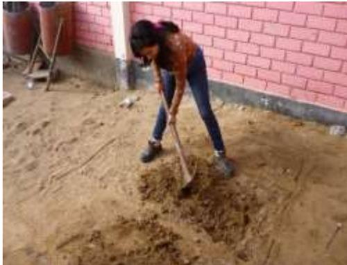
**Figura 66.** Realizando la excavación con pico en la calicata Nº1.
