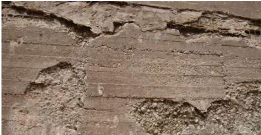
**Figura 28.** Erosión de una viga de concreto armado
