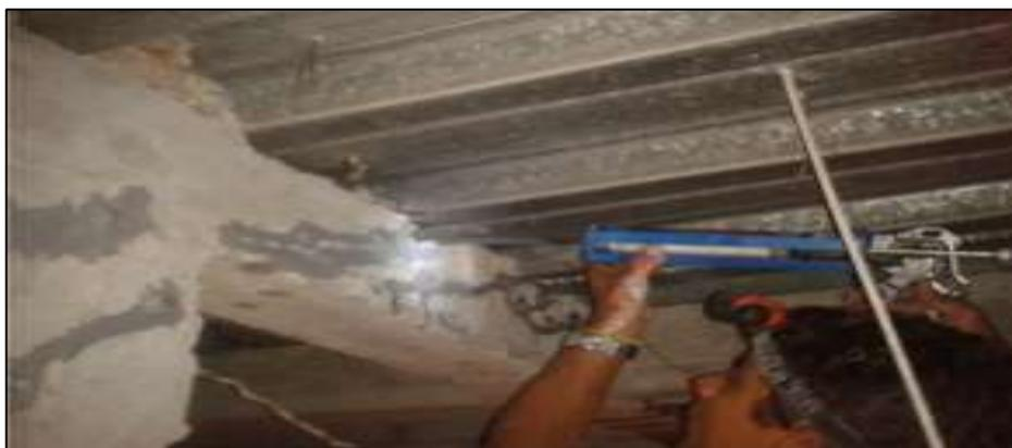
*Figura 31.* Aplicación del producto MASTER INJECT 1701 a una viga.
