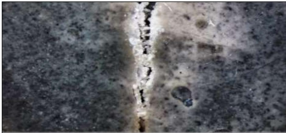
**Figura 29.** Reparación de fisuras con la utilización de biocemento.
