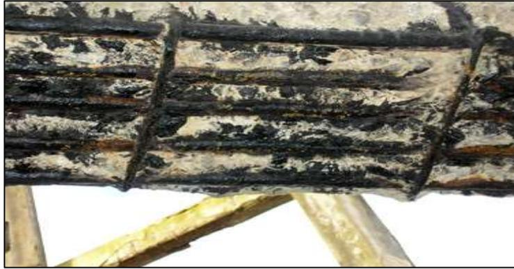
**Figura 27.** Corrosión de una viga de concreto armado
