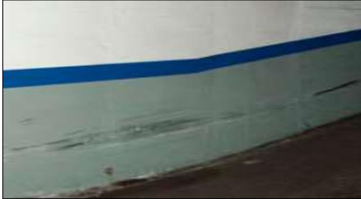
*Figura 24.* Erosión en una pared de un estacionamiento.
