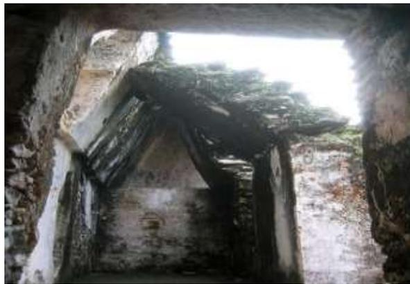
**Figura 15.** Deformación por desplome
