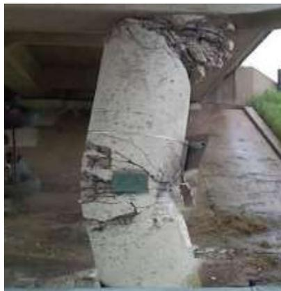
**Figura 16.** Deformación por pandeo
