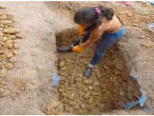
**Figura 68.** Realizando la excavación con pico en la calicata Nº3.
