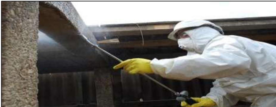
*Figura 30.* Aplicación del producto MasterProtect 8000 CI a una viga.
