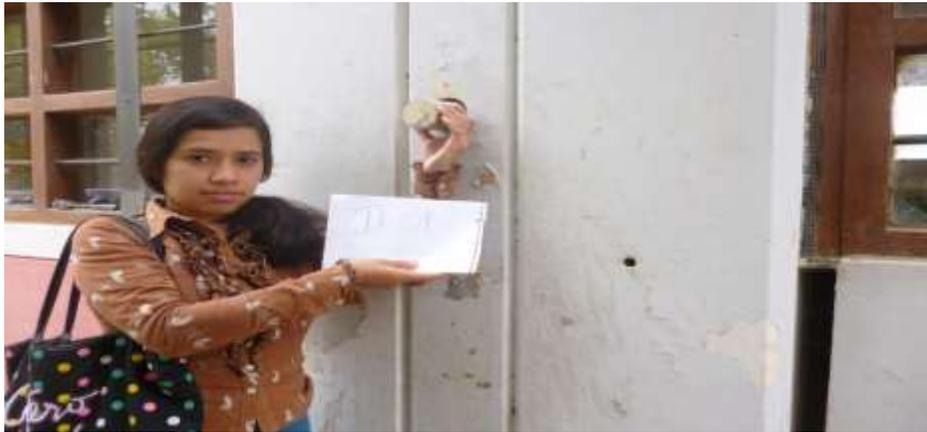
**Figura 116.** Punto de extracción de núcleo de concreto en una columna de una de las aulas de la Institución Educativas San Isidro.
