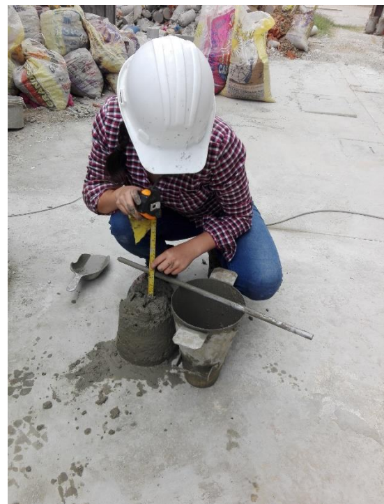
Figura 26. Asentamiento del concreto
