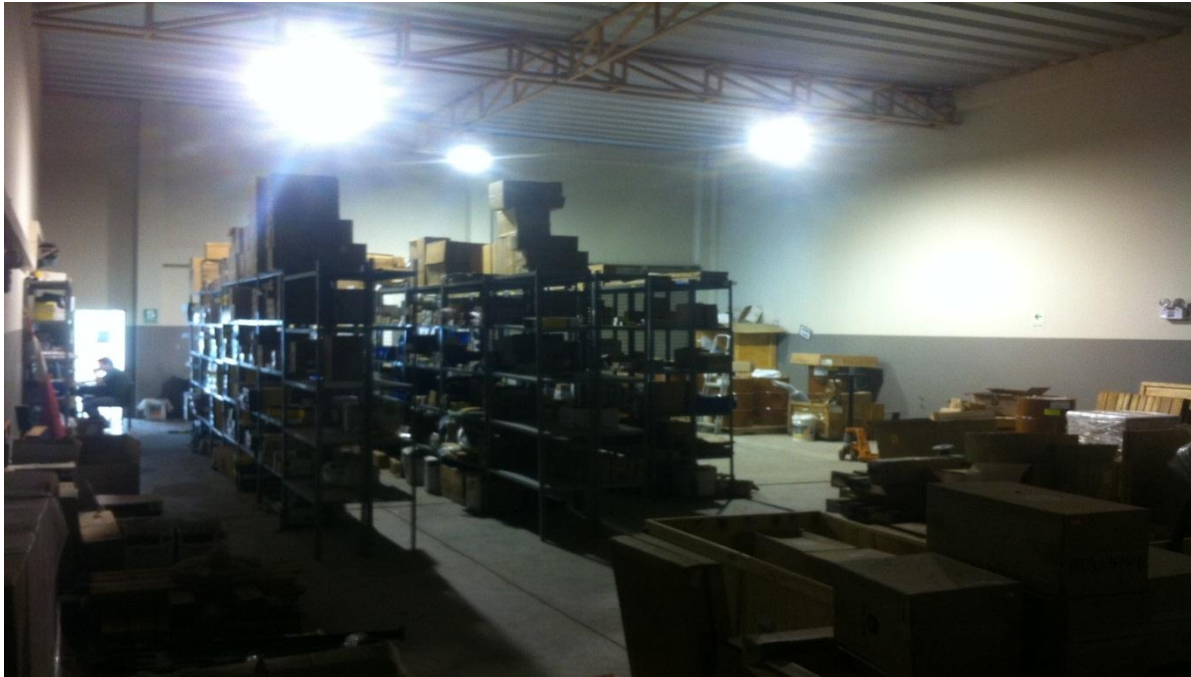
Figura 17: Baja iluminación en el almacén de la empresa Ipesa SAC.
