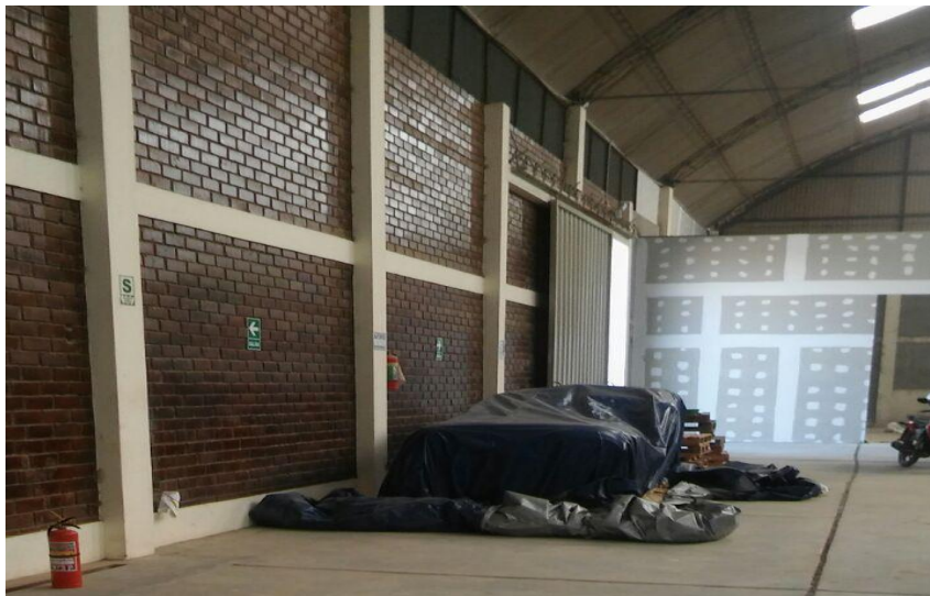
Figura 13: Sacos desordenados y extintor en el piso.
