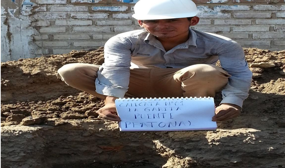
Ilustración 12. Calicata N°1 ubicada en el km 7+874 Autopista Pimentel-Chiclayo (Algarrobo). Profundidad de calicata 3 m.
