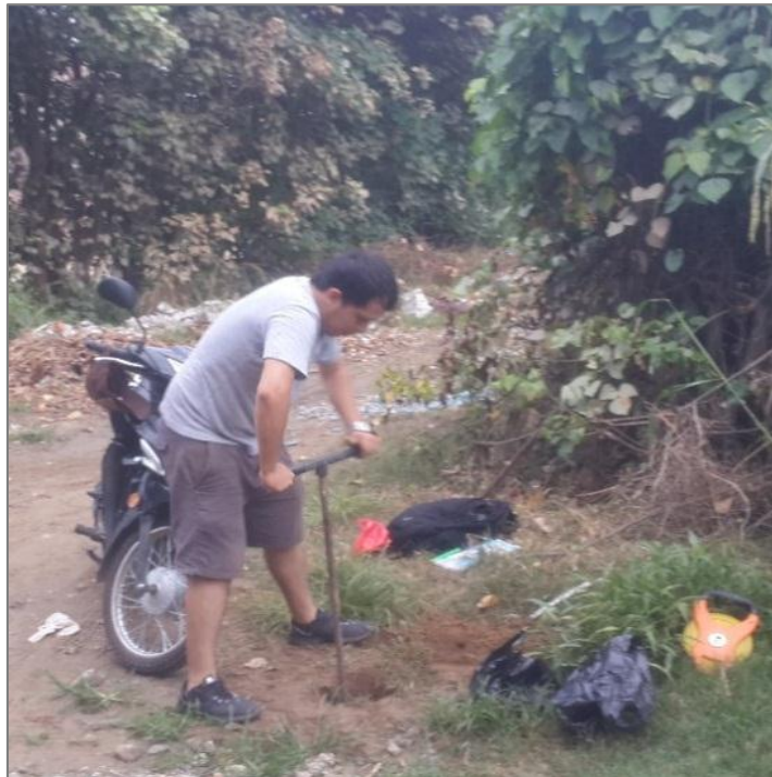
Figura 20. Uso de posteadora para extracción de muestra.
