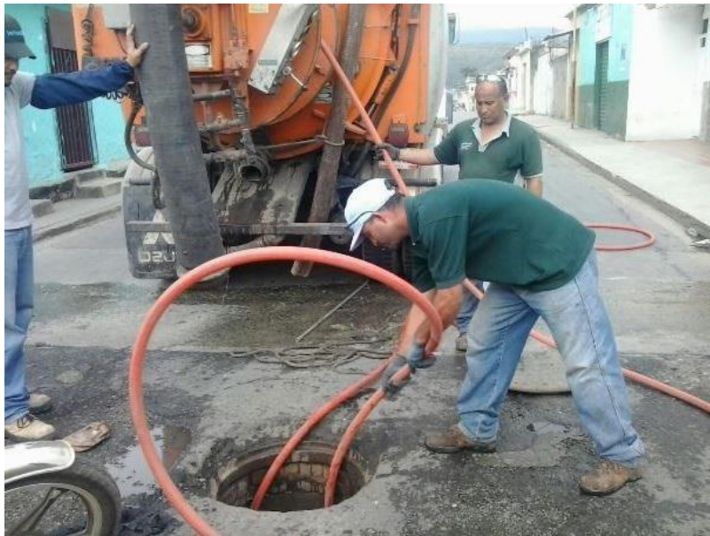
Figura 76. Limpieza de los tramos iniciales de los colectores
