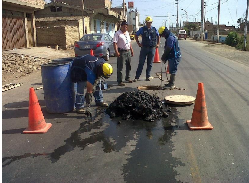
Figura 77. Limpieza manual de las alcantarillas.
