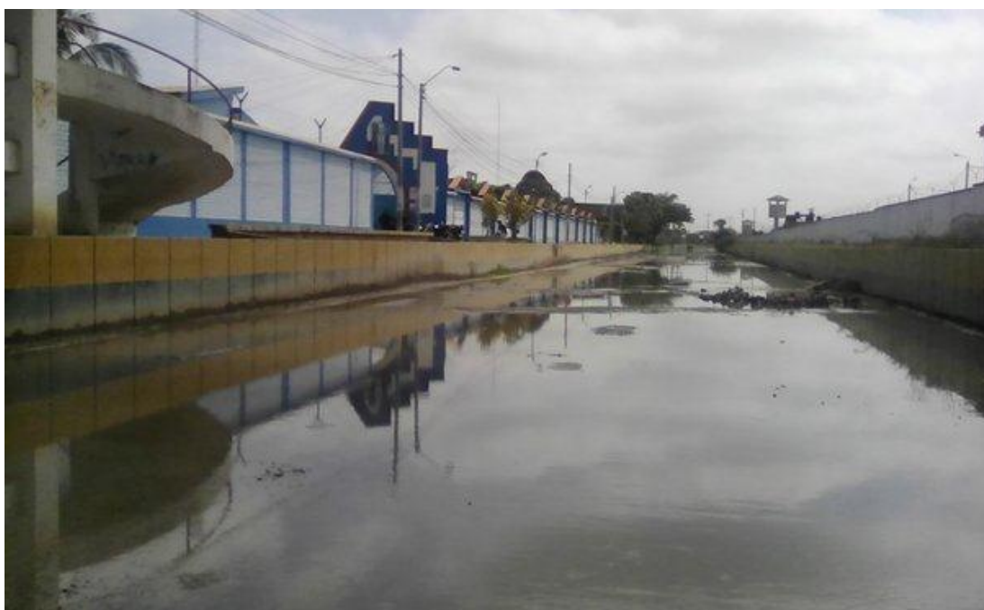
Figura 7. Colapso de desagüe en las calles de Tumbes.
