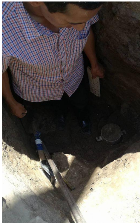
Figura 13 Extracción de muestras alteradas, con molde CBR
