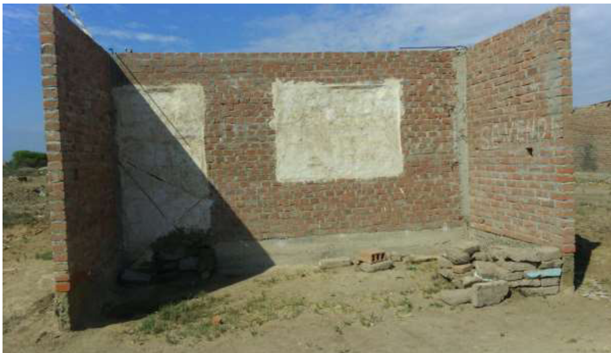
Lote sin energía eléctrica
