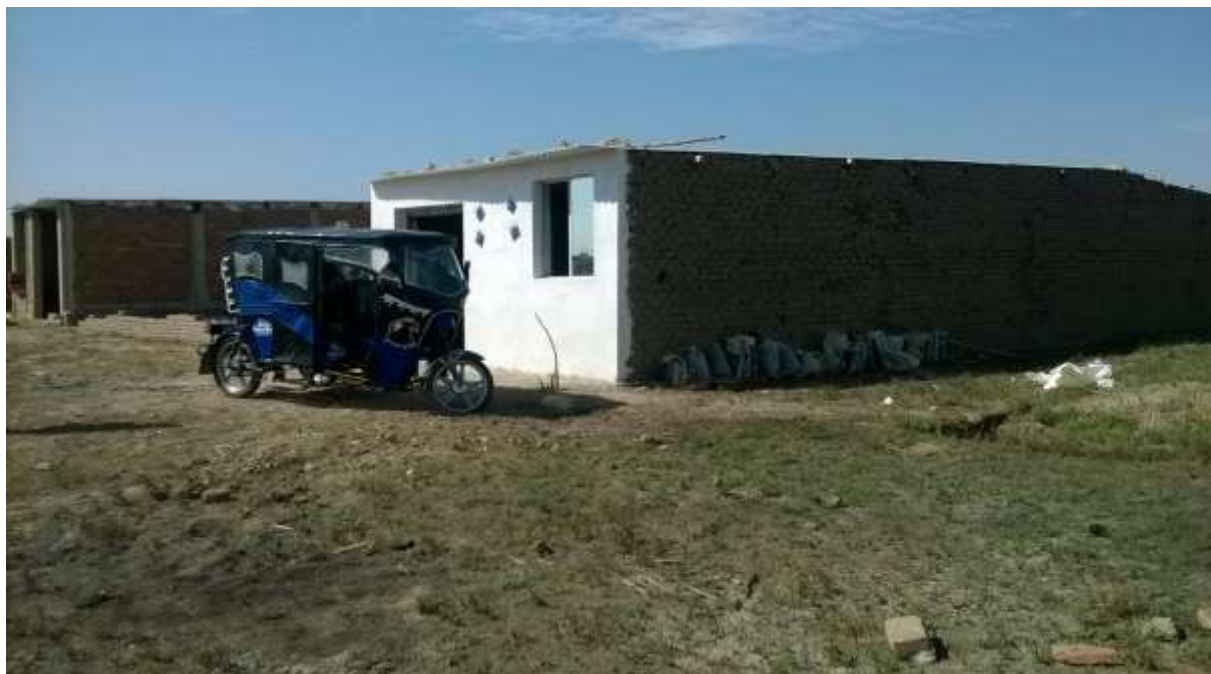
Vivienda de material rustico sin energía eléctrica
