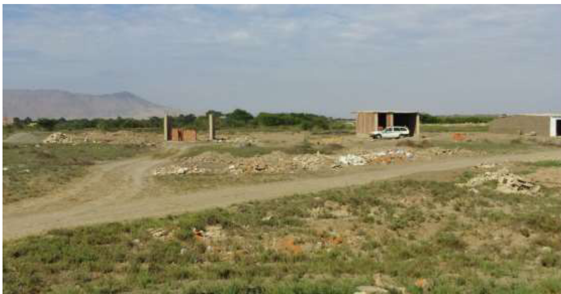
Proyección de vía que carece de servicio de energía eléctrica
