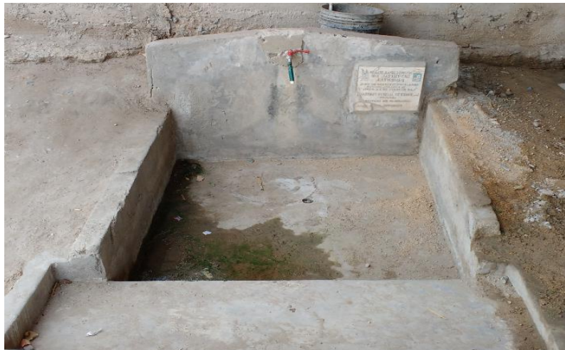
Figura 2: Pileta pública ubicada en el centro de la localidad, brindada por el Alcalde Roberto Jacinto Purizaca en el año 2006.
