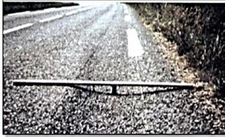
**Figura 17:** Deformación continua longitudinal gravedad 3: Profundidad mayor a 4 cm
