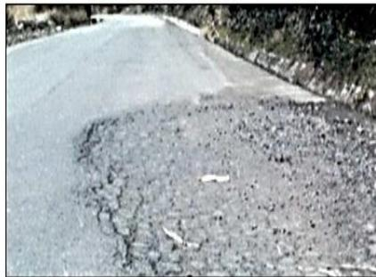
**Figura 19:** Deformación (3b hundimientos) gravedad 3: Profundidad mayor 4 cm.
