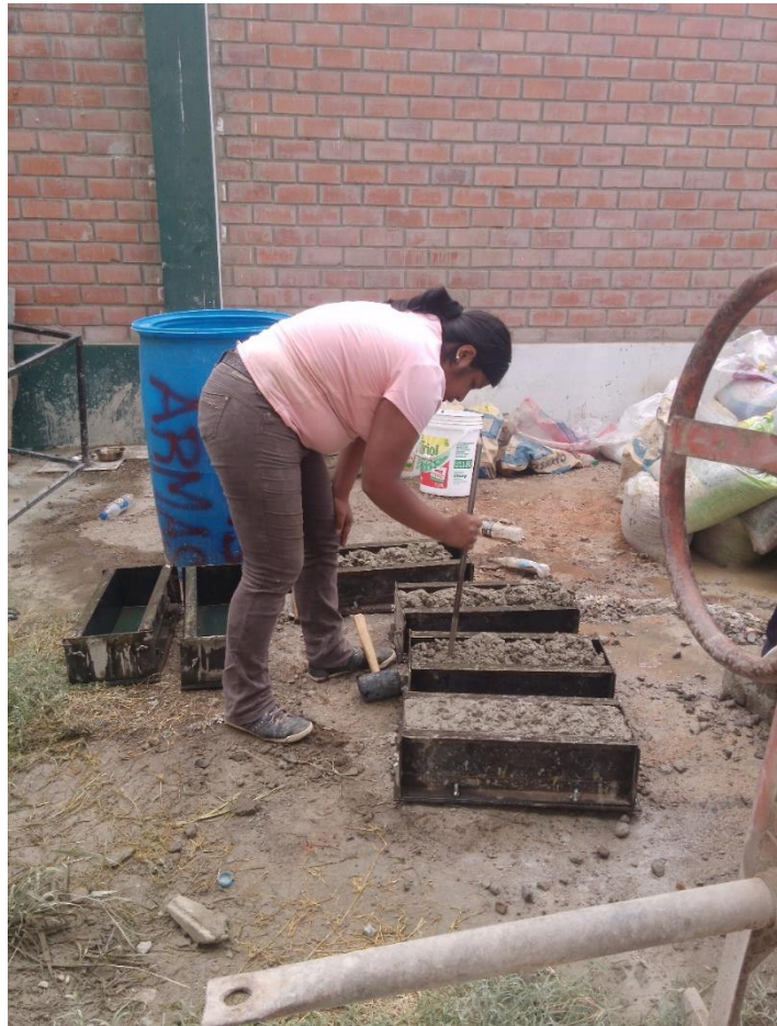
Foto 19: Elaboración de vigas
