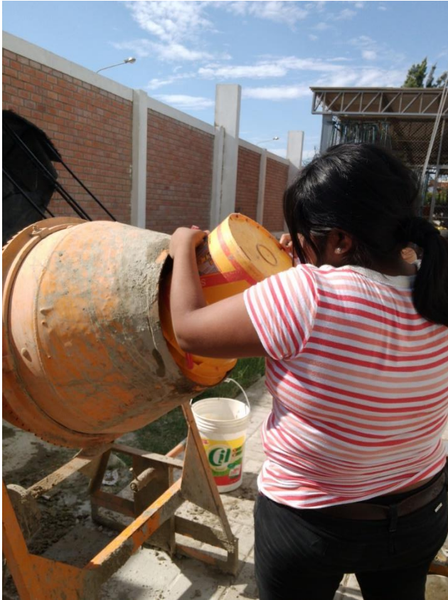
Foto 11: Elaboración del concreto
