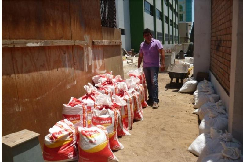
Se observa el almacenamiento de los agregados en sacos, primera adquisición de materiales, 1 m<sup>3</sup> de arena y 1 m<sup>3</sup> de piedra ½" procedentes de las canteras La Victoria y Tres Tomas, respectivamente.
