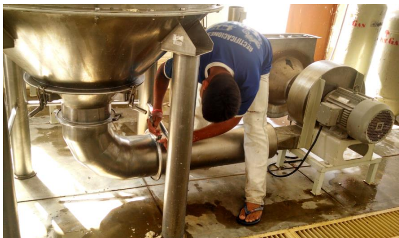
Figura N° 13: Reparación de la Deshidratadora Industrial
