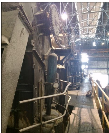
Figura D.1.63. Pasadizo de trapiche, segundo piso.
