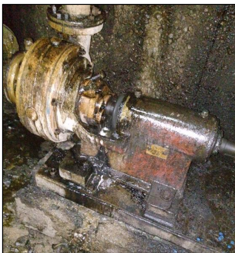
Figura D.1.83. Fuga de jugo encalado.
