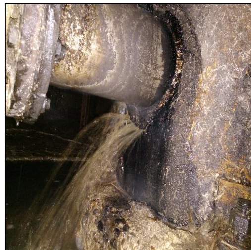
Figura D.1.84. Fuga de jugo clarificado.
