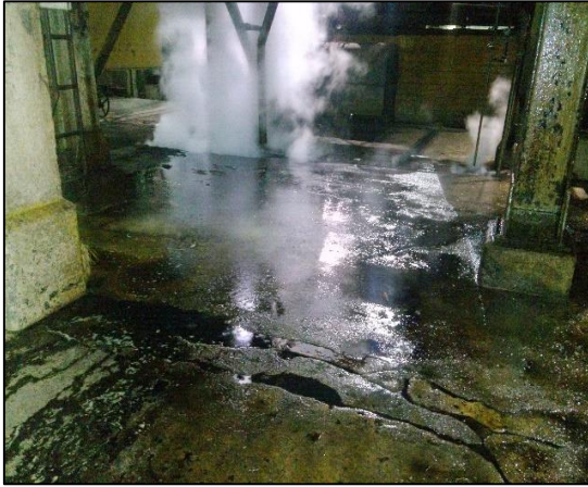
Figura D.1.79. Derrame de jugo clarificado.
