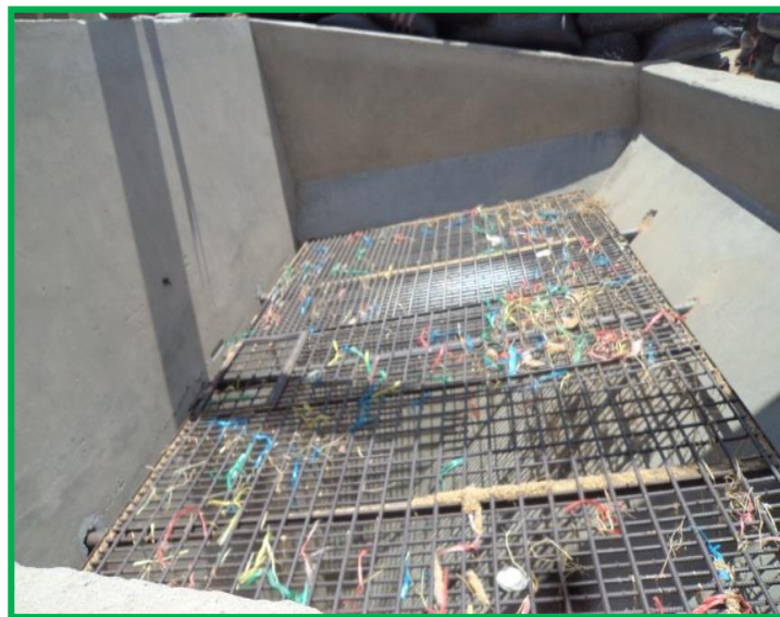
Figura 64: Desperdicios encontrados entre pajarrafia y otras cosas.
