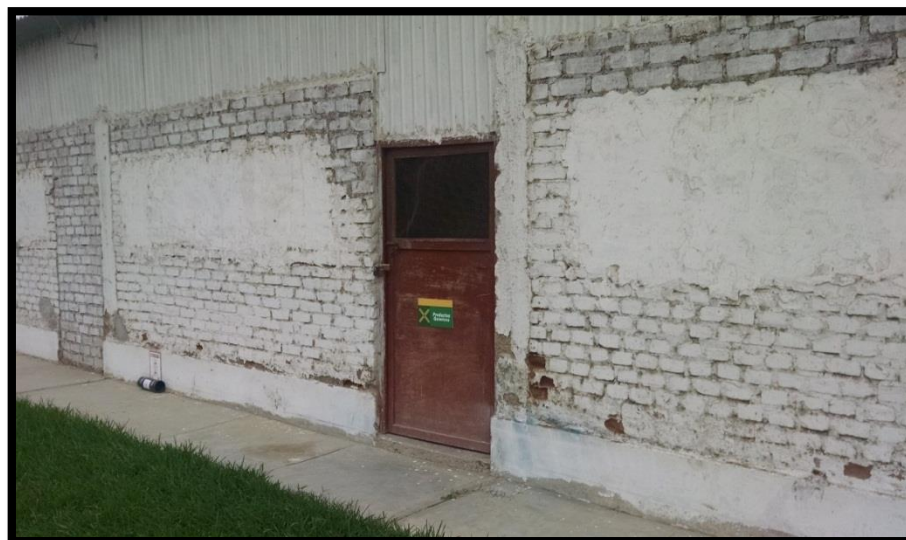
Figura N° 09: Falta de una Adecuada Señalización
