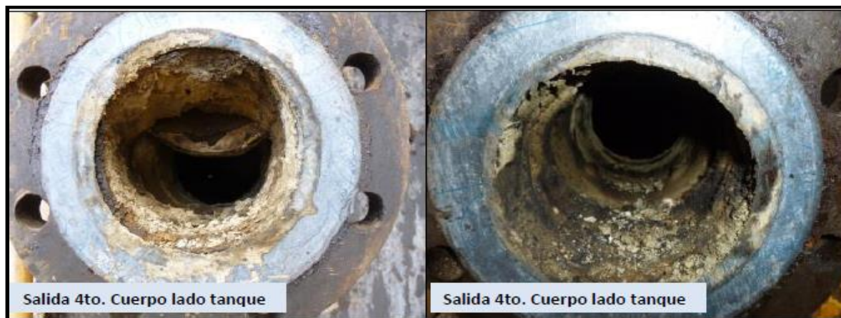
Figura 25 salida del tanque
