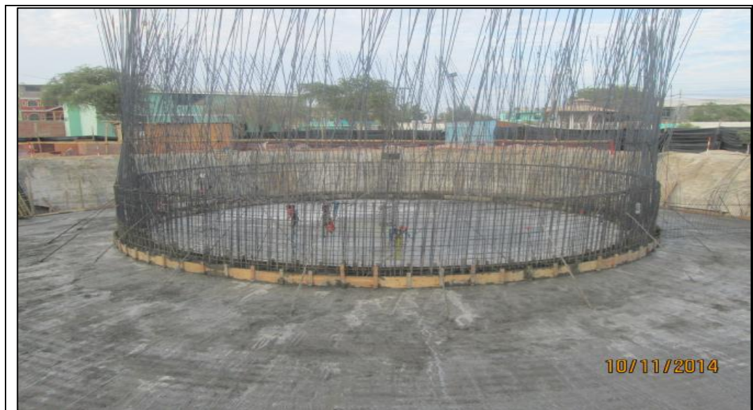
Fotografía 20: Cimentación de reservorio y viga F. Fuente: Propia
