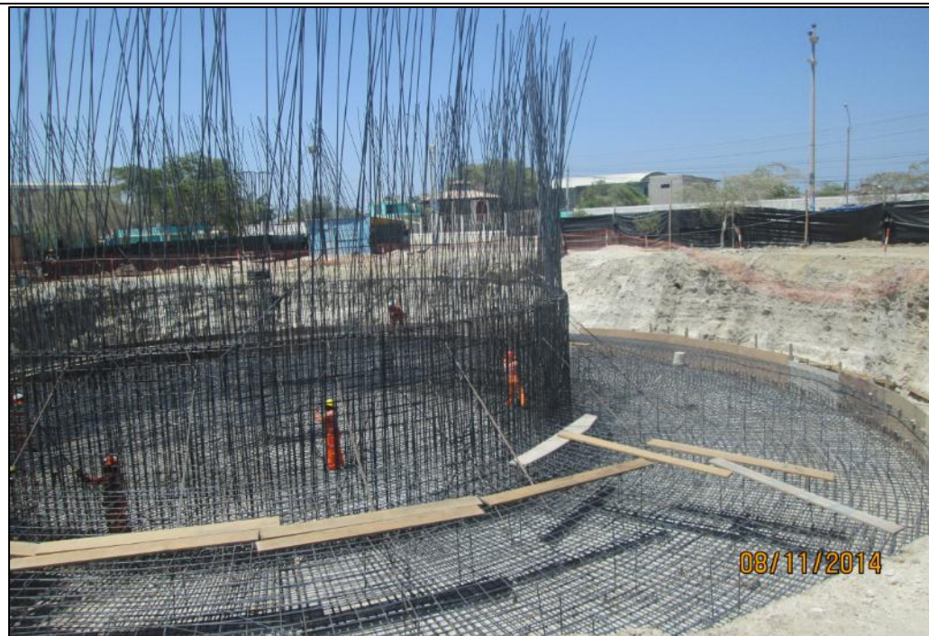
Figura 27: Encofrado y habilitación de acero para viga de cimentación de reservorio Fuente: Propia
