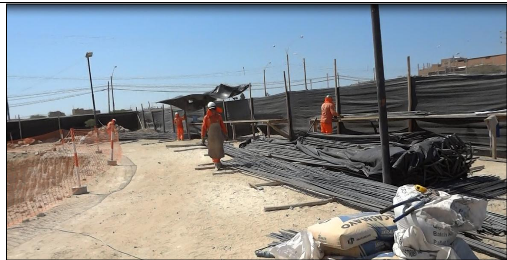
Figura 25: Habilitación de acero para viga de cimentación de reservorio Fuente: Propia
