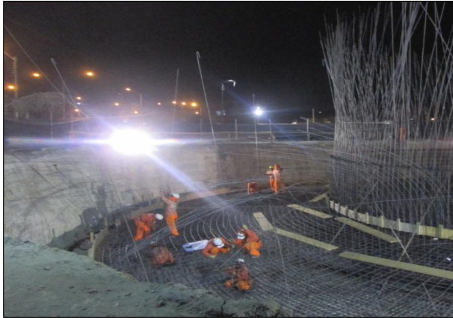
Figura 26: Habilitación de acero para viga de cimentación de reservorio Fuente: Propia
