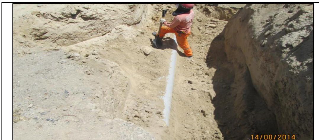
Figura 5: Descubrimiento de tubería existente
