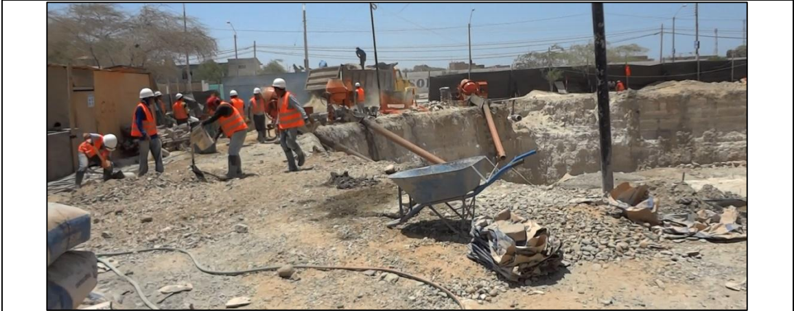
Figura 23: Vaciado de solado en cimentación de reservorio – Posición 1 Fuente: Propia
