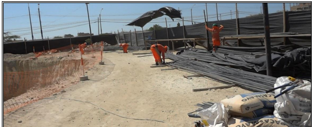
Fotografía 17: Corte de acero – Posición 1 Fuente: Propia
