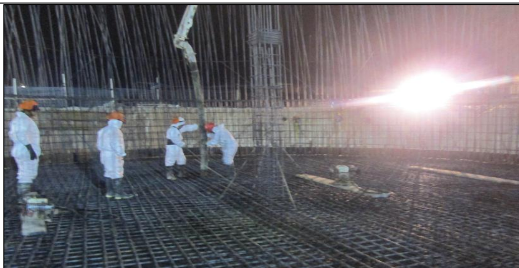
Figura 30: Vaciado de concreto en viga de cimentación de reservorio – Detalle de actividades de 4 trabajadores Fuente: Propia
