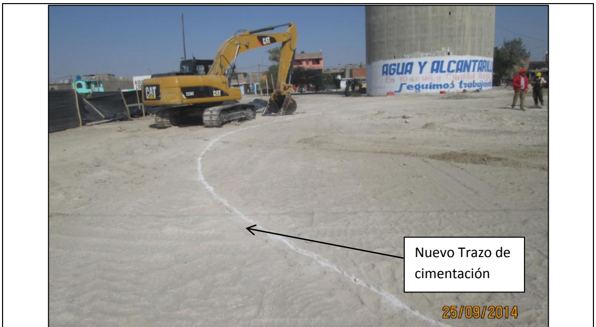
Figura7: Nuevo trazo de cimentación (Tubería reubicada y tapada)
