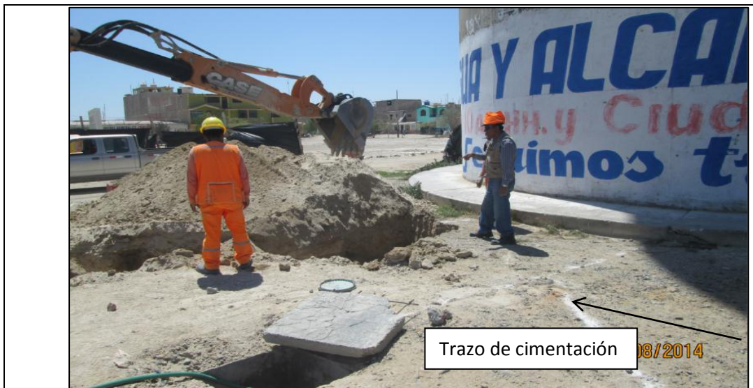
Figura 4: Trazo de cimentación y hallazgo de tubería existente
