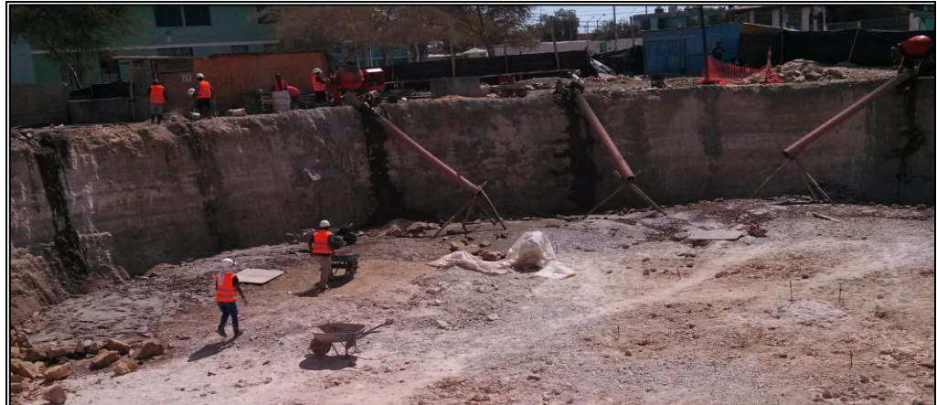
Fotografía 19: Vaciado de solado en cimentación de reservorio – Posición 3 Fuente: Propia
