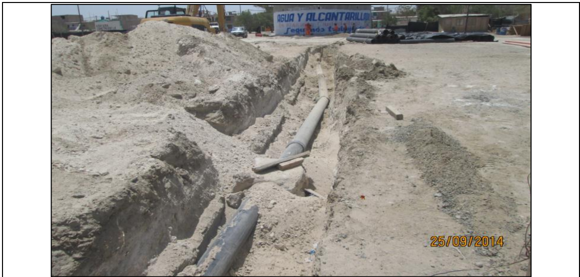
Figura 6: Tramo de tubería a reubicar
