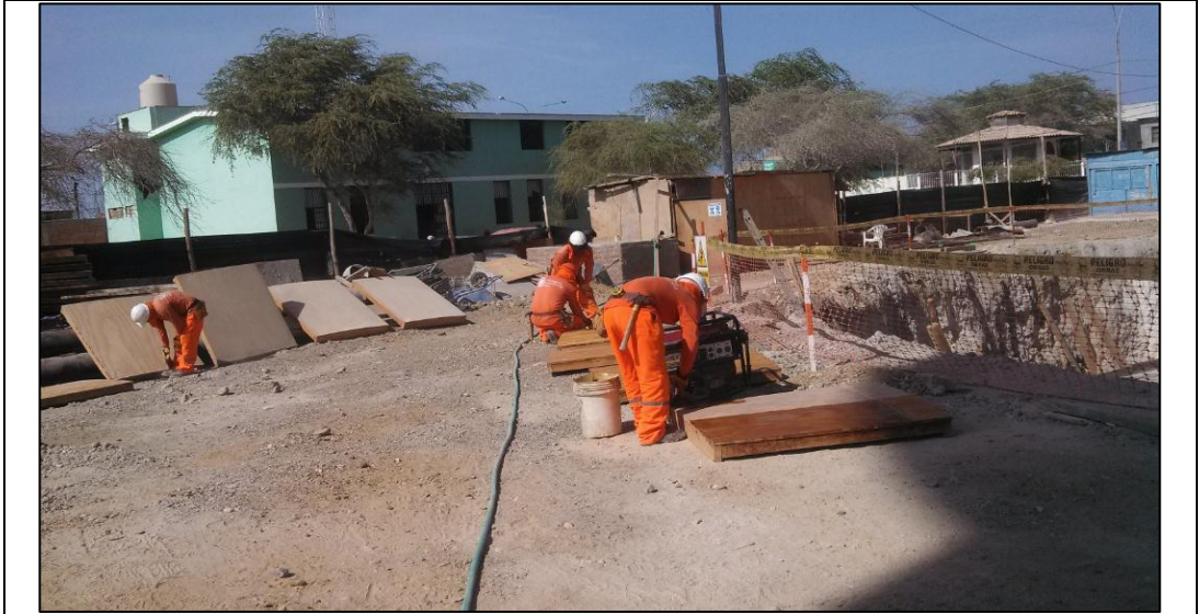
Figura 28: Habilitación paneles para viga de cimentación de reservorio Fuente: Propia
