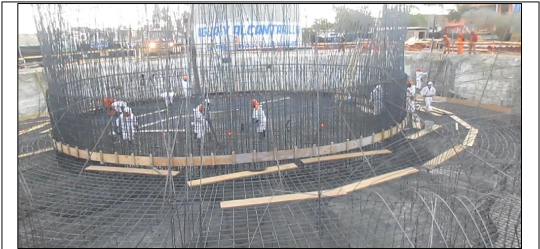
Figura 29: Vaciado de concreto en viga de cimentación de reservorio Fuente: Propia
