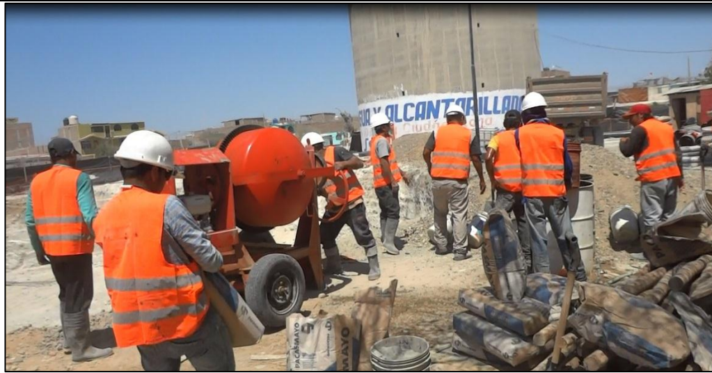
Figura 24.- Vaciado de solado en cimentación de reservorio – Posición 2 Fuente: Propia
