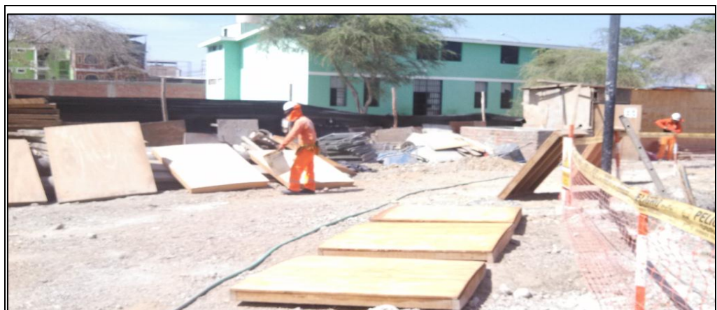
Fotografía 18: Habilitación de paneles para encofrados – Posición 2 Fuente: Propia
