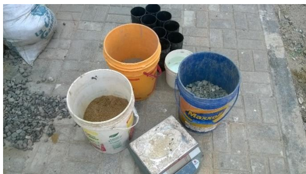
Foto N° 10 Preparación de la mezcla de concreto
