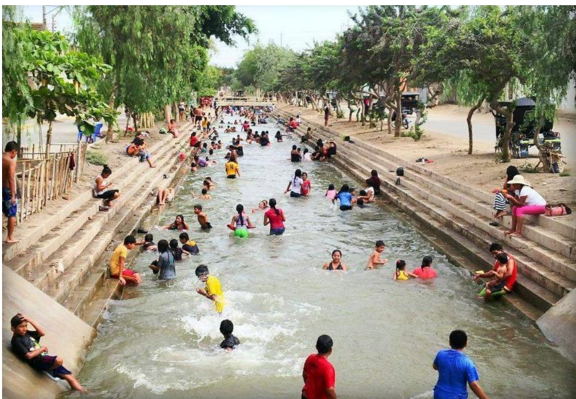
Img.30: Acequia “El Pueblo” – zona los ojitos. Fuente: Propia-trabajo de campo.
