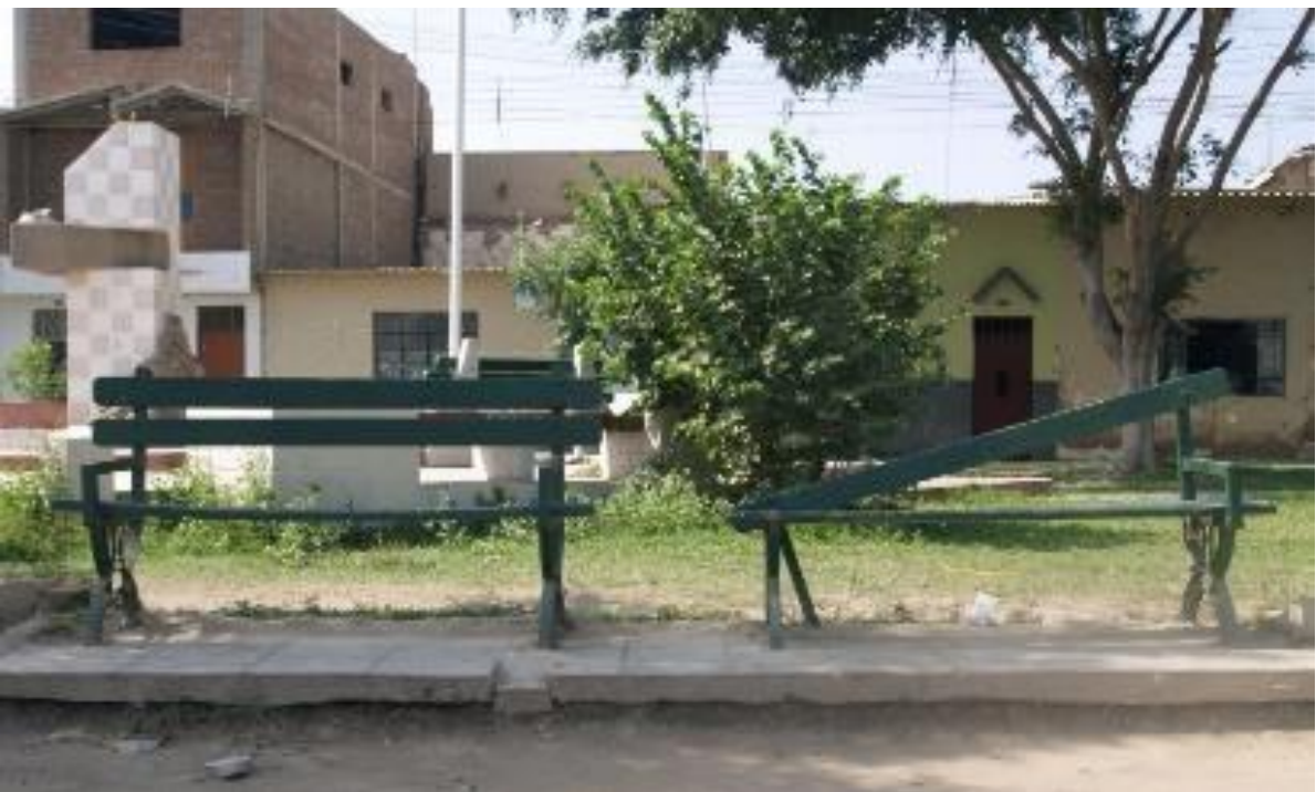
Img. 05: Mobiliario en mal estado de conservación en los espacios públicos.
