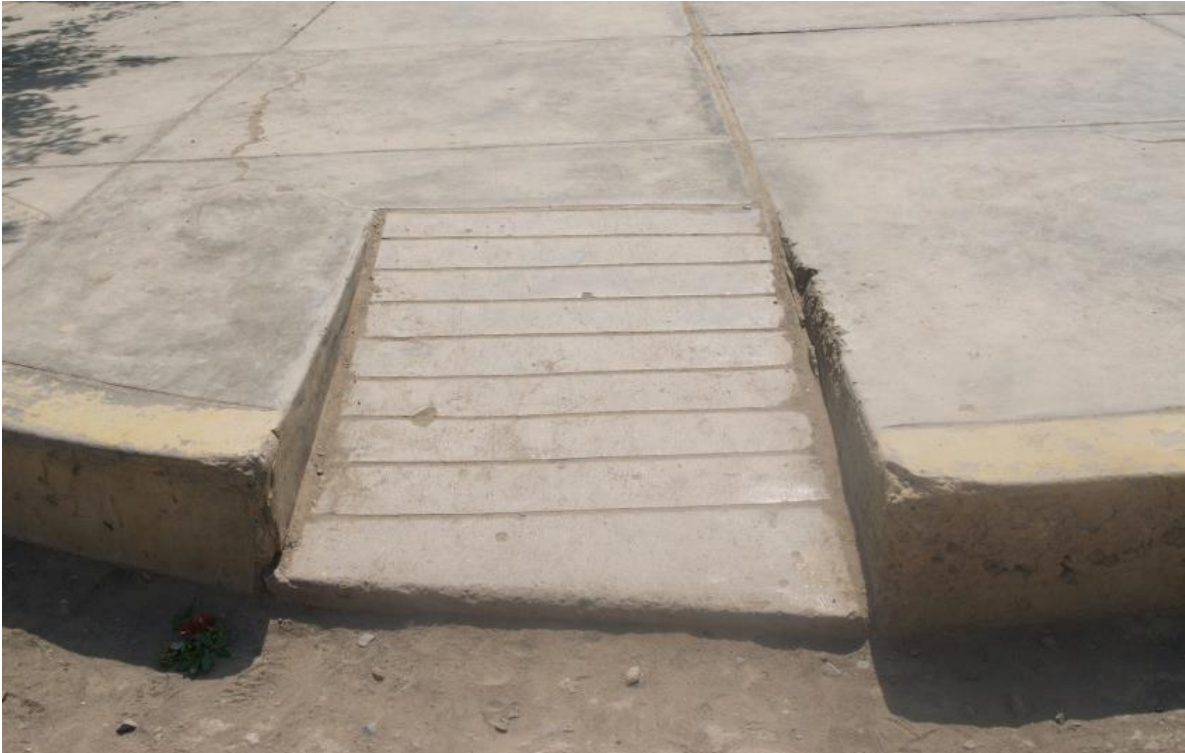
Img. 03: Rampas inadecuadas en los espacios públicos.
