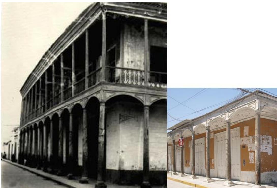
Img.51: Los portales estado antiguo – estado actual. Fuente: Centro fotográfico “Yashica” / propia.
