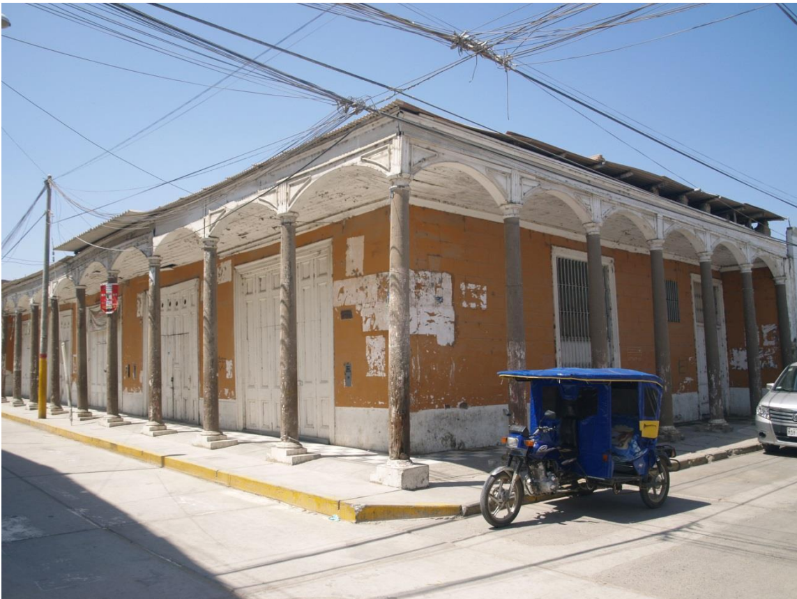
Img.24: Los Portales. Fuente: Propia-trabajo de campo.
