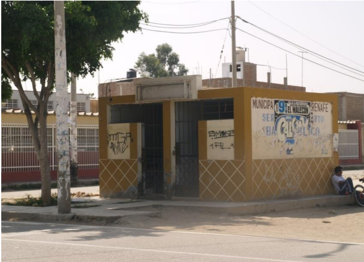
Img. 04: Baños cerrados en los espacios públicos.
