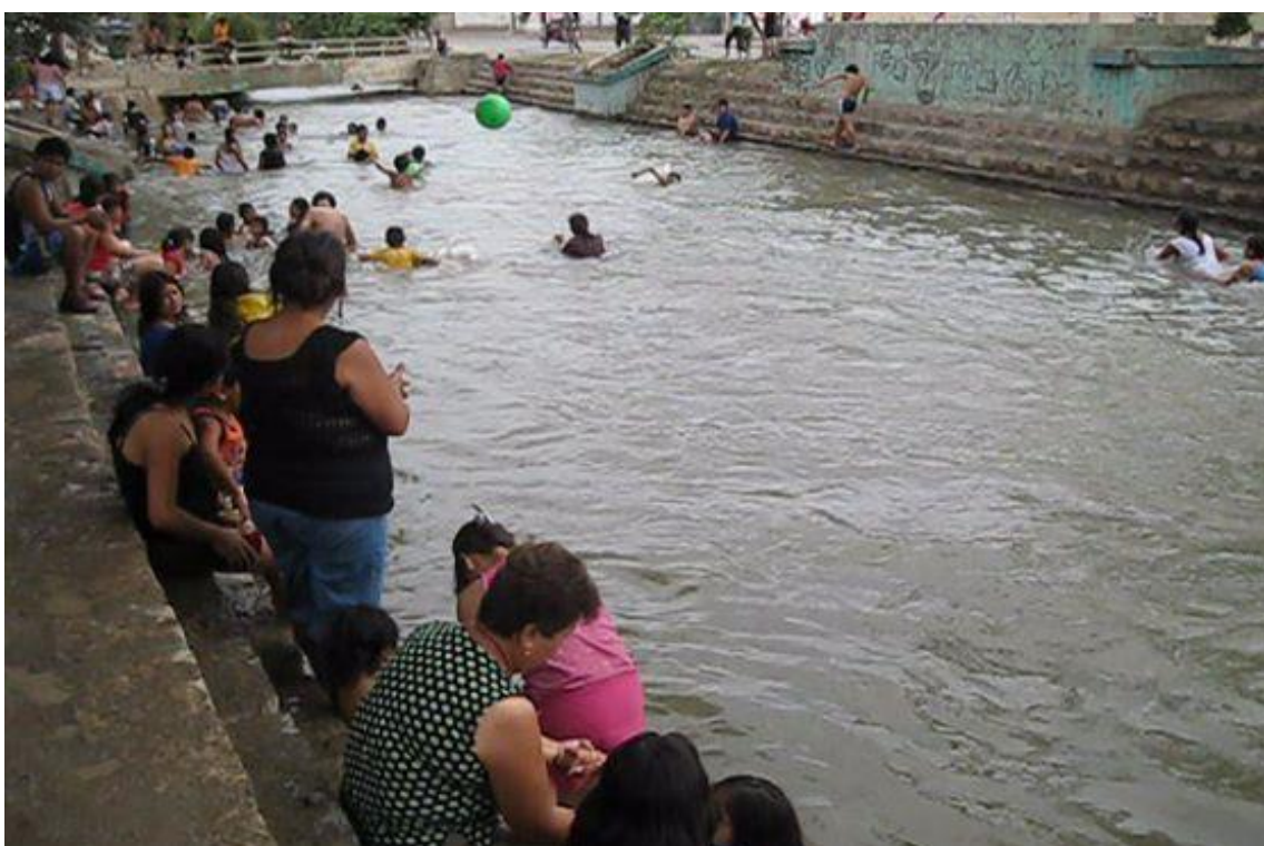
Img.28: Acequia "El Pueblo" – zona los ojitos. Fuente: Propia-trabajo de campo.
