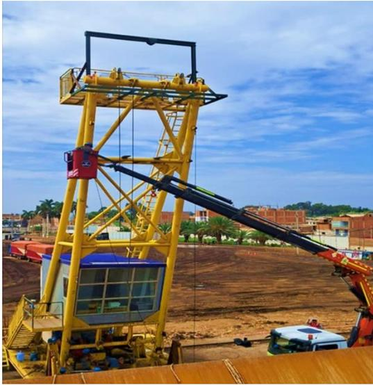
**Anexo N° 01.** *Desmontaje, revisión y cambio de bronces en poleas de izaje de balancín, así como cambio de cable de izaje de la grúa hilo*
