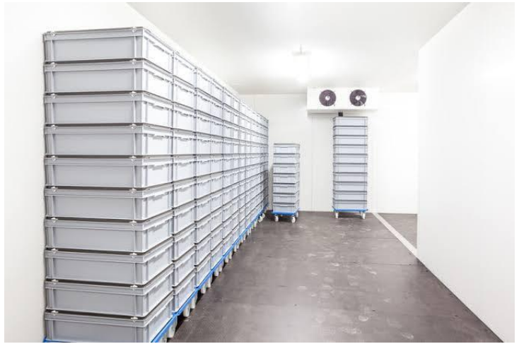
Figura 7: Instalación de un sistema de aire acondicionado en el área de almacenamiento
