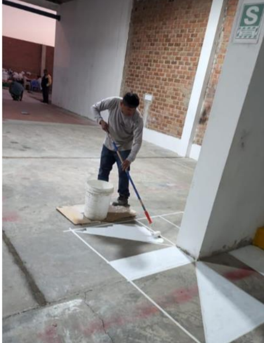
Figura 25. Señalización del área de mantenimiento
