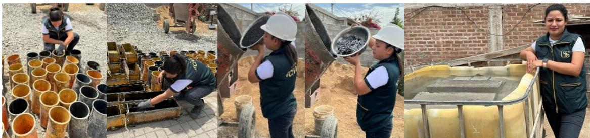
**Fig. 19.** Preparación de moldes cilíndricos y vigas, elaboración y curado del concreto.
