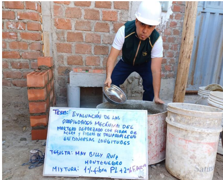
Fig. 19 Colocación de mortero Mixtura:1%FA+2%FPP en muretes para ensayo de compresión
