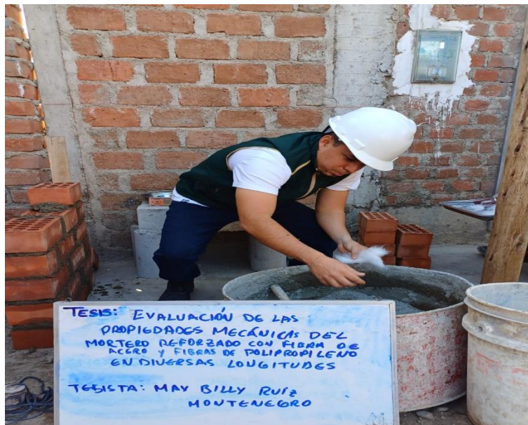
Fig. 20 Colocación de mortero Mixtura:1%FA+2%FPP en muretes para ensayo de compresión
