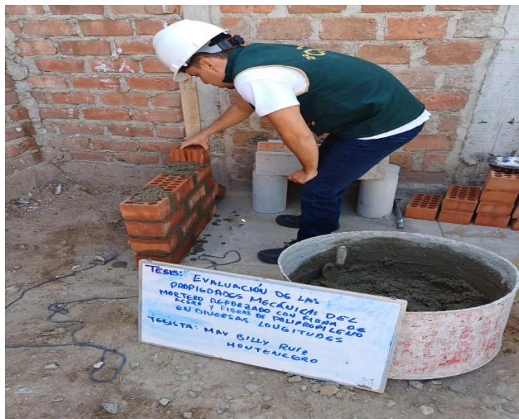
Fig. 18 Colocación de mortero Mixtura:1%FA+2%FPP en muretes para ensayo de compresión
