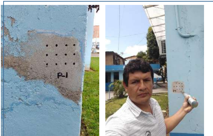
Figura 49 Señalizando los puntos de lectura (a y b)
