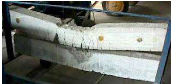
Figura 4. Deformación por flecha
