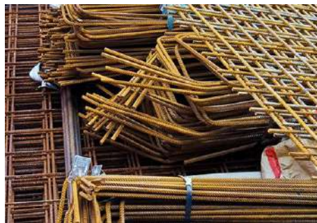
Figura 12. Oxidación en los aceros estructurales
