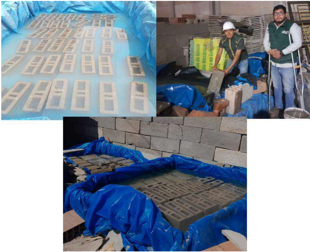
Fotografía 17. Curados de bloques de concreto
