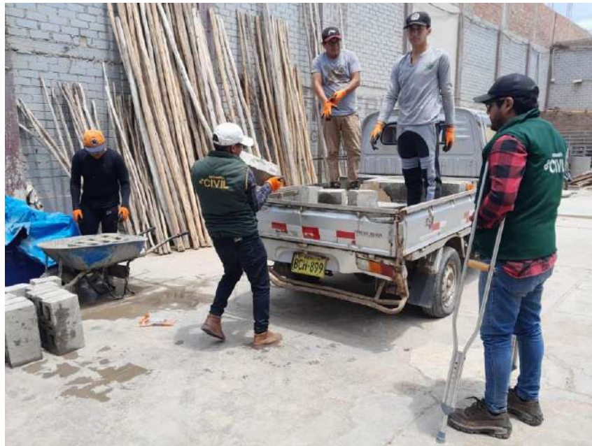
Fotografía 18. Movilización de los bloques curados.
