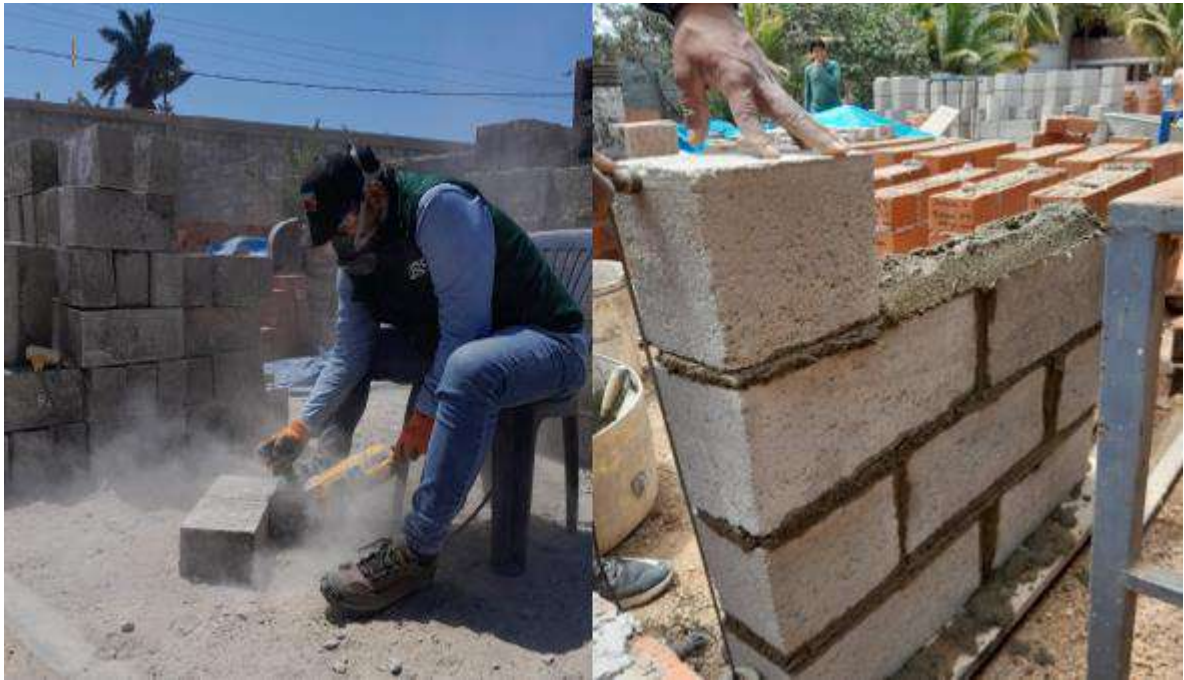
Fotografía 19. Cortado de bloques para su posterior uso en muretes.
