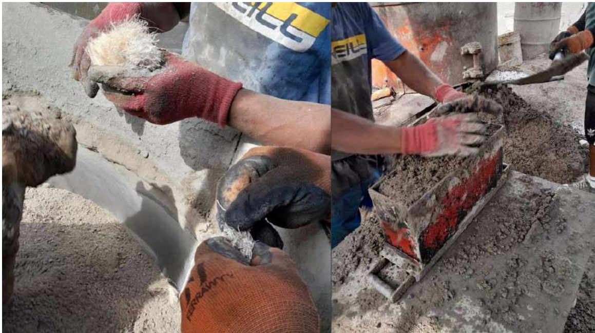
Fotografía 16. Elaboración de bloques de concreto - patrón
