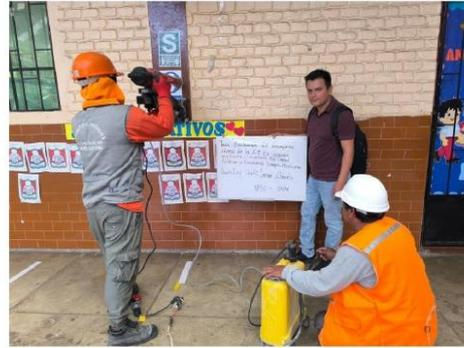
FOTO 10: EXTRACCION DE TESTIGO
