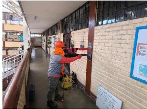
FOTO 02: EXTRACCIÓN DE TESTIGO
