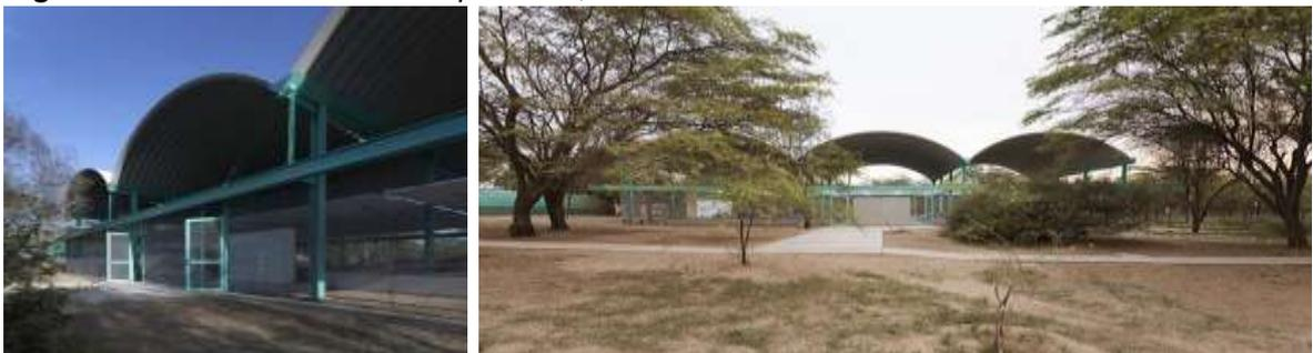
Nota. Cobertura que busca calibrar el aire en el interior y responde a las condiciones climáticas. [Fotografía], Losada, 2015. <https://www.archdaily.pe/pe/774963/taller-de-arquitectura-en-el-desierto-jorge-losada>
